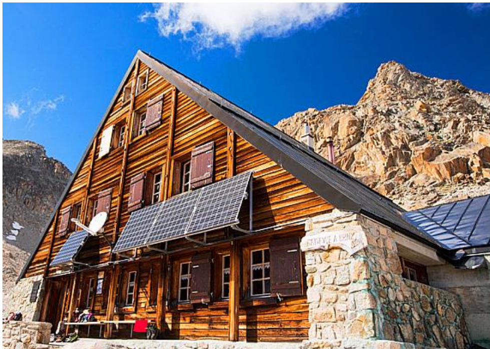
Obrázek 4: Ukázka horské chaty off-grid využívající solární panely, Švýcarské Alpy (zdroj: Nature picture library)
