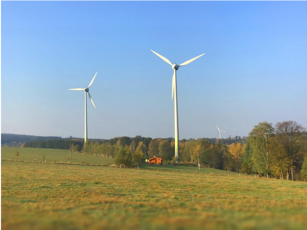
Obrázek 19: Větrná turbína v Jindřichovicích pod Smrkem (zdroj: EIC Jindřichovice pod Smrkem)
