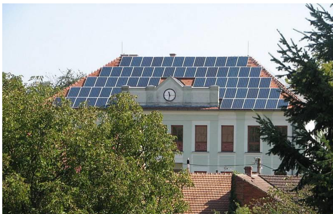
Obrázek 22: FVE na obecním úřadu v obci Modrá (zdroj: Skalička, 2009)
