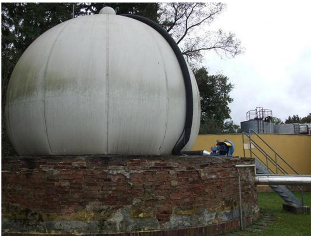
Obrázek 26: Plynojem u ČOV v Pelhřimově (zdroj: MÚ Pelhřimov)
