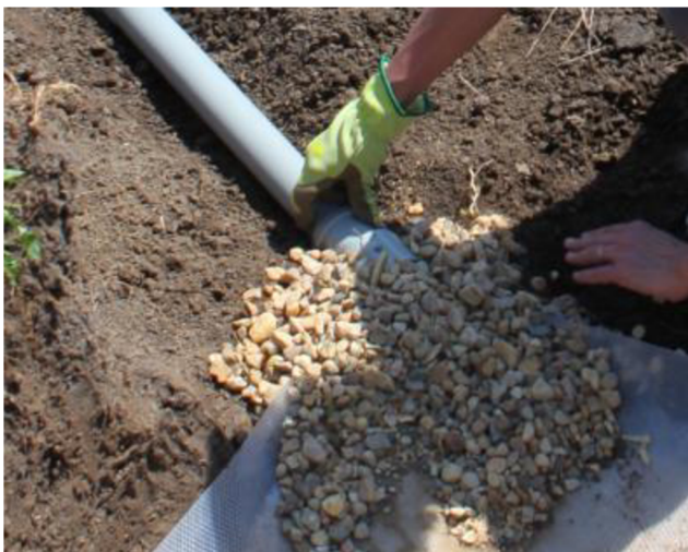
Obrázek 18 - Detail nátoku do potrubí (Ing. Michal Kriška, Ph.D)
