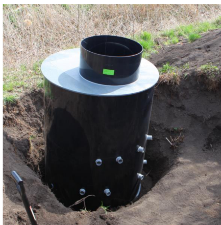
Obrázek 16 - Vodoměrná šachta (Ing. Michal Kriška, Ph.D.)
