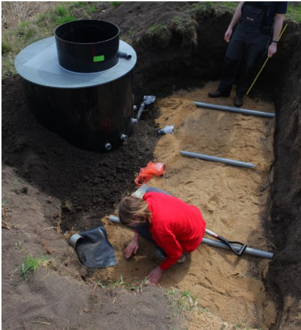
Obrázek 17 - Uložení potrubí (Ing. Michal Kriška, Ph.D.)
