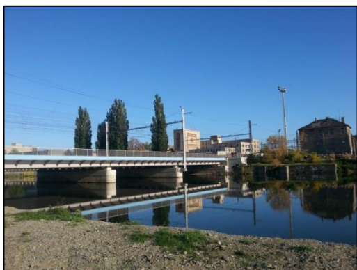
Obr. 68 Železniční most Zdroj: N. Cigánková, říjen 2015
