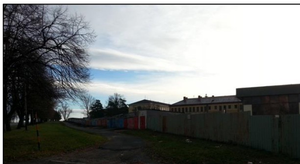
Obr. 88 Areál kasáren Želátovská Zdroj: N. Cigánková, listopad 2015
