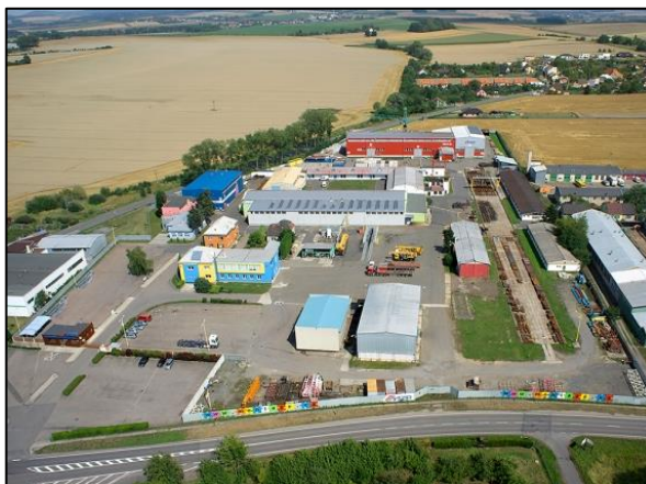
Obr. 39 Montáže Přerov a.s.
