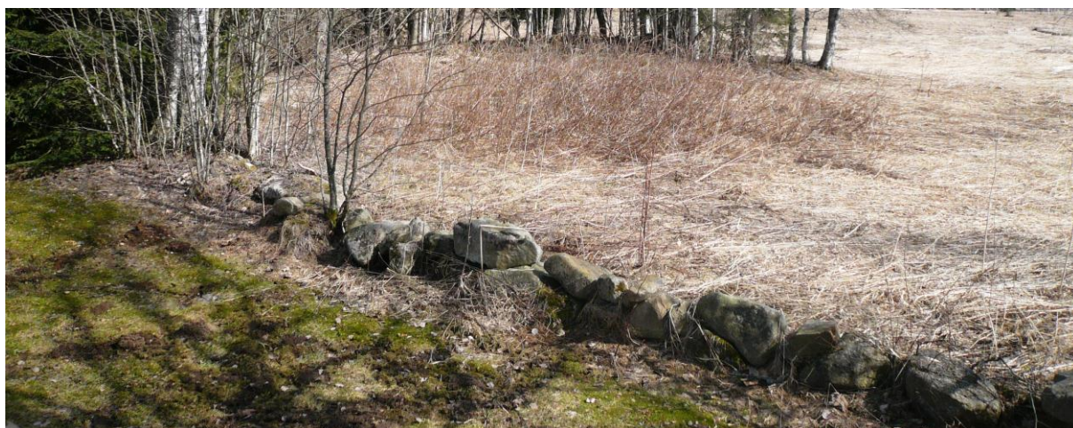
Obrázek 33: Zbytky rozebraného tarasu. (foto autor)
