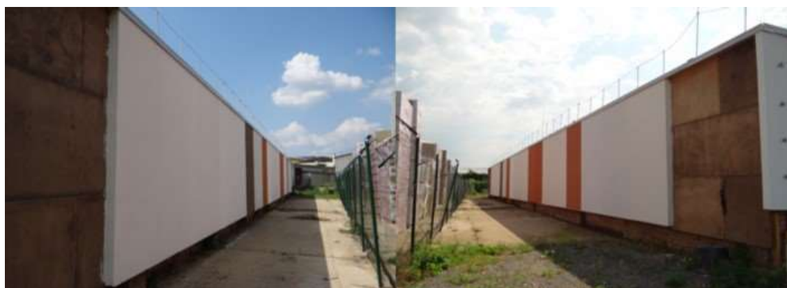
Obr. č. 13 - Celkový pohled na východní fasádu
