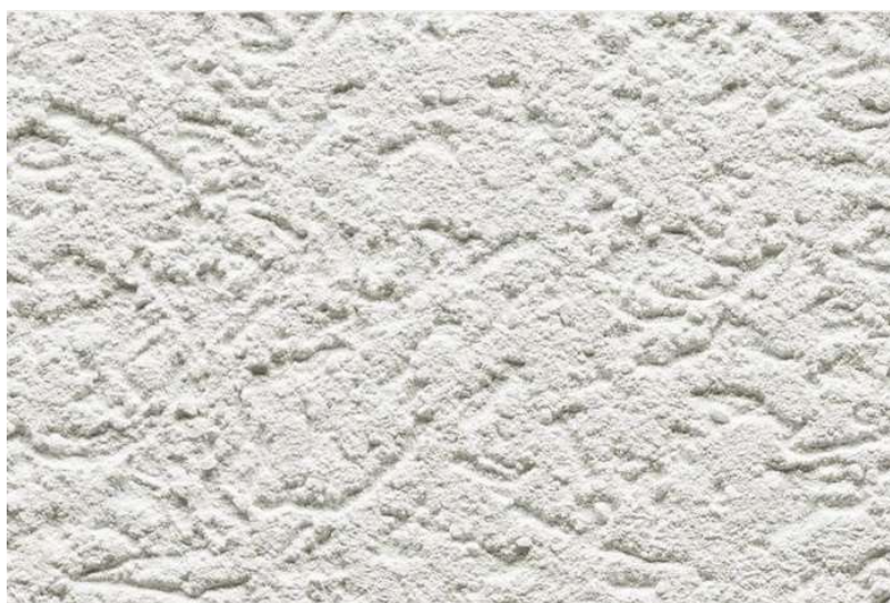
Obr. č. 4 - Struktura fasádní omítky [4]
