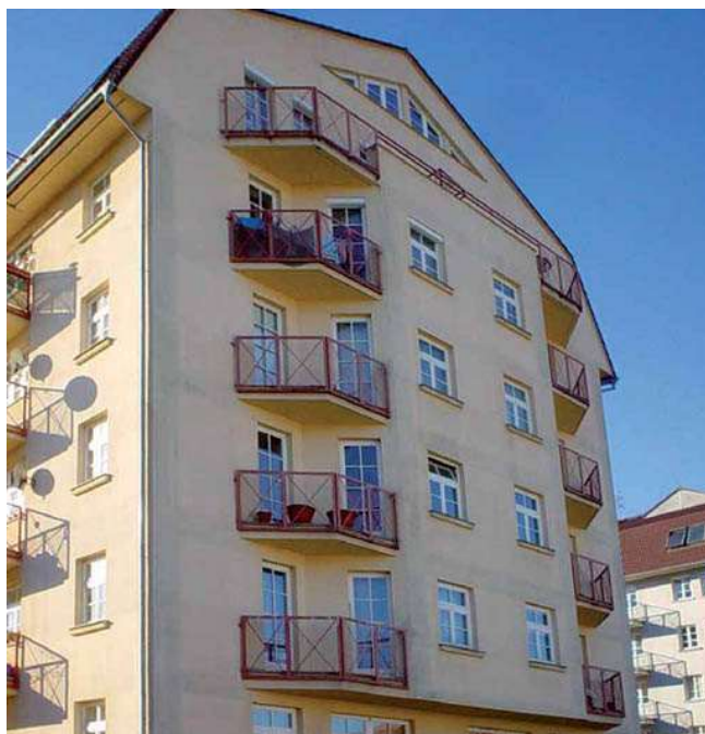
Obr. č. 5 - Prokreslení konstrukce vlivem termoprecipitace [2]
