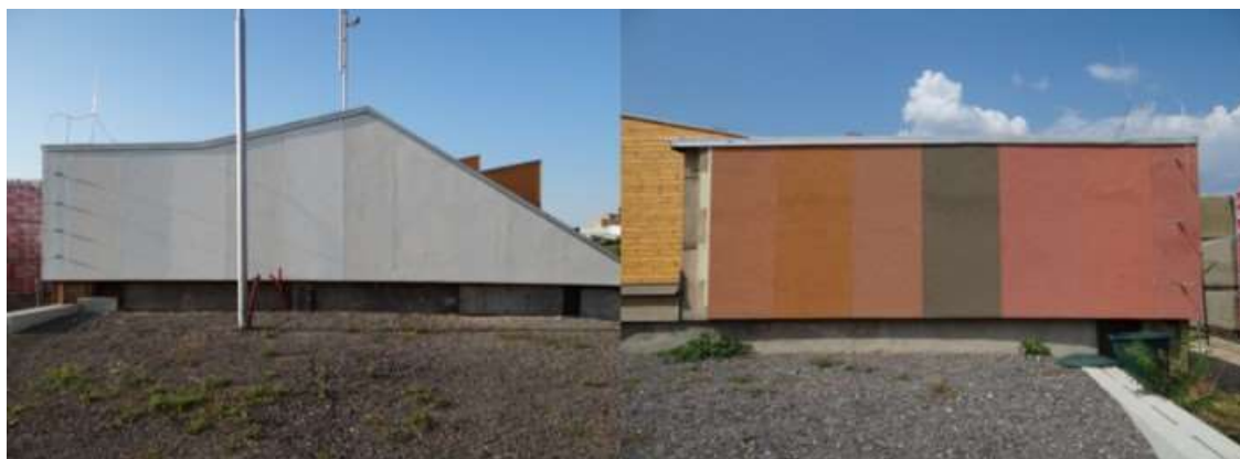
Obr. č. 12 - Celkový pohled na severní (vlevo) a jižní (vpravo) fasádu
