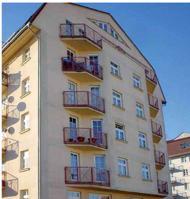
Obr. č. 5 - Prokreslení konstrukce vlivem termoprecipitace [2]
