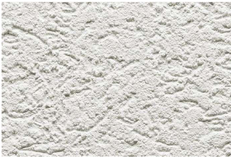
Obr. č. 4 - Struktura fasádní omítky [4]
