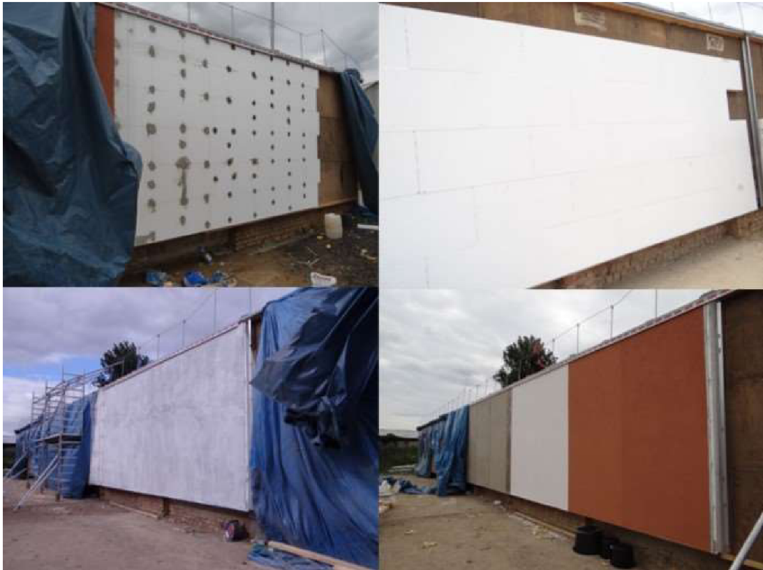
Obr. č. 11 - Příprava vzorků fasád
