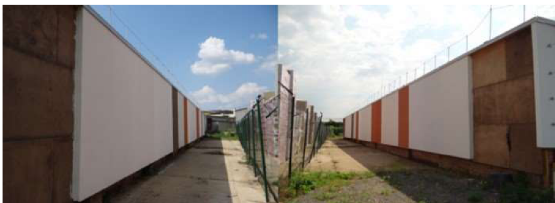
Obr. č. 13 - Celkový pohled na východní fasádu
