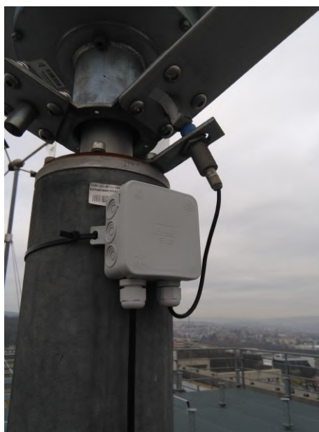
Obr. 2.1: Instalace snímače otáček
