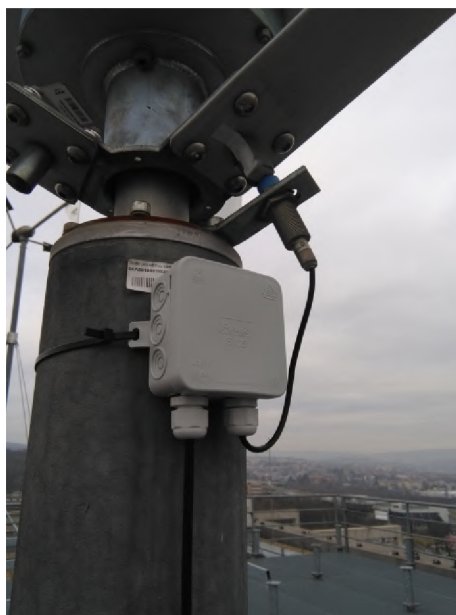
Obr. 2.1: Instalace snímače otáček
