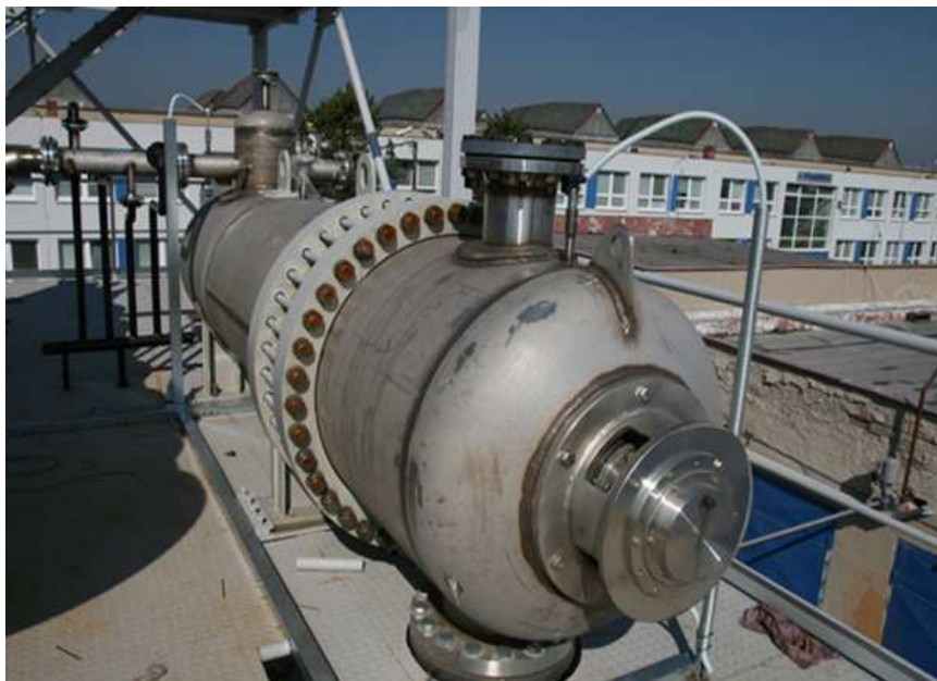
Obrázek č. 8: Konstrukční řešení vysokotlakého hydrolyzérou firmy Pharmix
