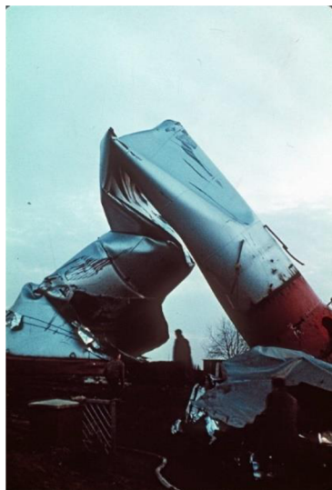
Obr. 15 – Zborčený vodojem [17].
