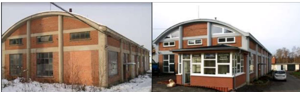
Obrázek 5: Budova firmy MH-plast, s. r. o. před rekonstrukcí a po rekonstrukci
