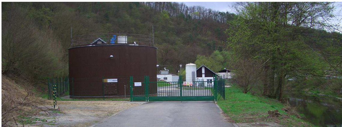
Obrázek 9: Příjezdová cesta k ČOV Bílovice nad Svitavou
