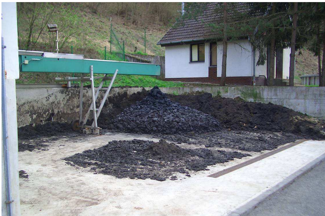
Obrázek 21: Odvodněný kal, který je šnekovým dopravníkem přepraven na deponii
