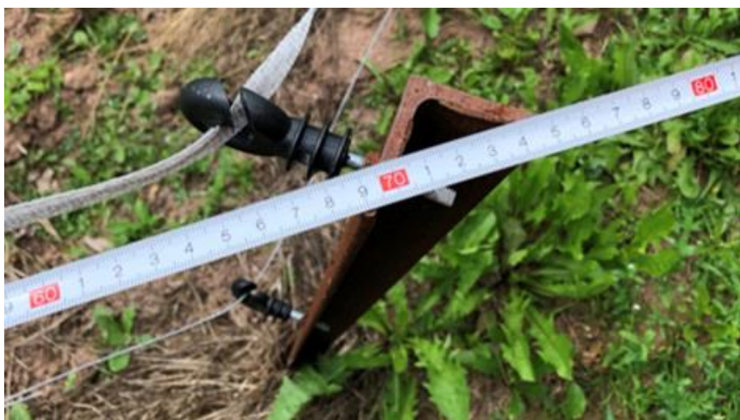
Obrázek 12: Ocelový kolík s izolátory (zdroj: KULHÁNEK, 2021 - archiv autora)
