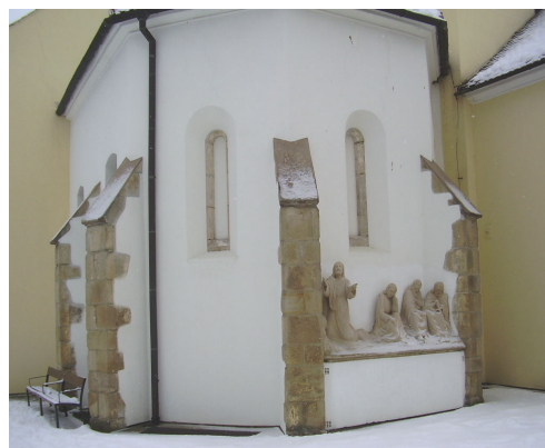
Opěrný systém vnější strany pětibokého závěru.
