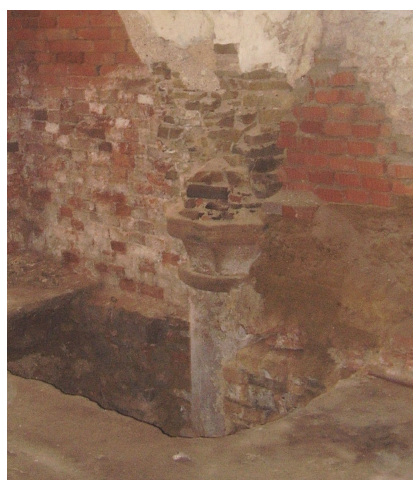
Dochovaná část středověkého sloupu.
