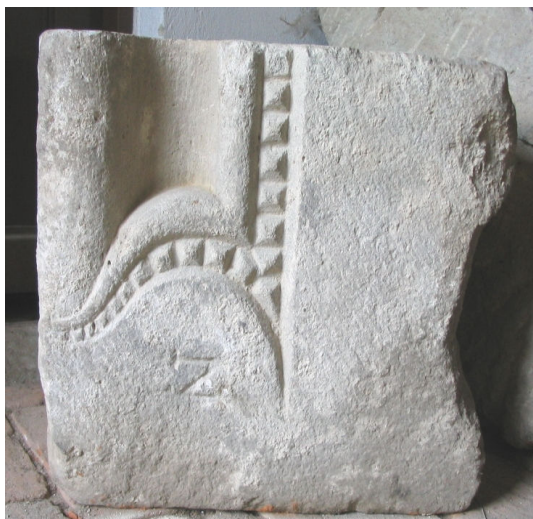
Trnož kamenného ostění s kamenickou značkou ve tvaru písmene „Z“ nebo „N“. (foto Radim Vrla)
