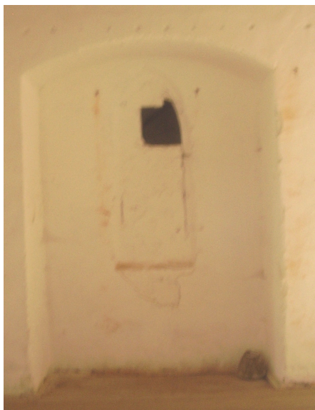
Zazděné okno s hrotitým záklenkem.
