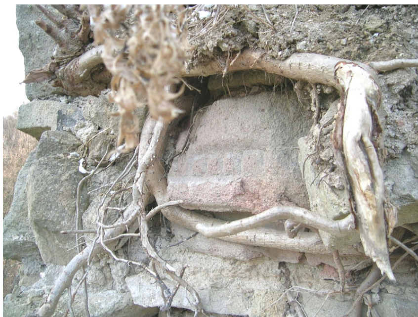
Kamenný blok zasazený v jádru jihovýchodní nároží obvodového zdiva hradního jádra. Na hraně je patrné diamantování. Článek byl obnažen po destrukci amorfního zdiva v roce 2003. Nachází se na původním místě. (foto Radim Vrla)
