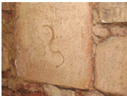
Kamenická značka ve tvaru dvou obloučků, střední oblouček není její součástí, neodpovídá tomu hloubka rýhy.
