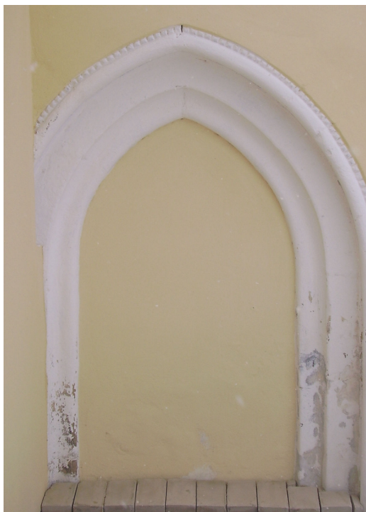
Zazděný portál s hrotitým záklenkem.
