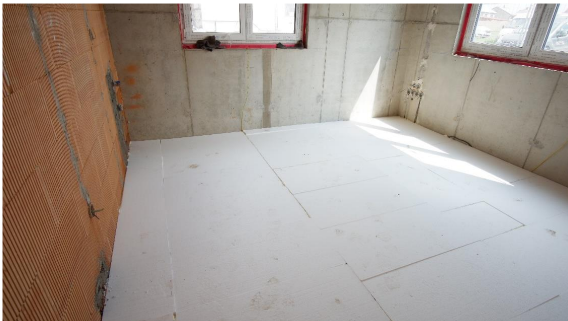
Obr. 45 [Položení tepelné izolace]
