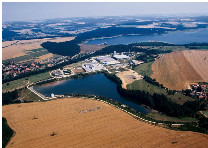
Obr. 7.5 Letecký pohled na ÚV Želivka a vodní nádrž Švihov[23]
