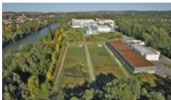
Obr. 7.11 Letecký pohled na ÚV Méry sur Oise [28]
