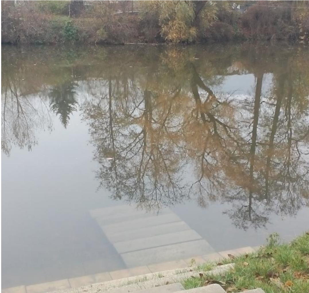
Obr. 8.2 Místo odběru surové vody [autor]
