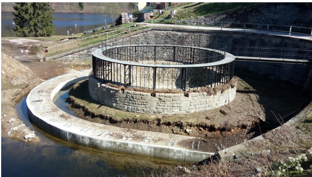
Obrázek č. 15 Právě probíhající osazování hrubých česlí na vodním díle Labská, duben 2018. Autor: vlastní.
