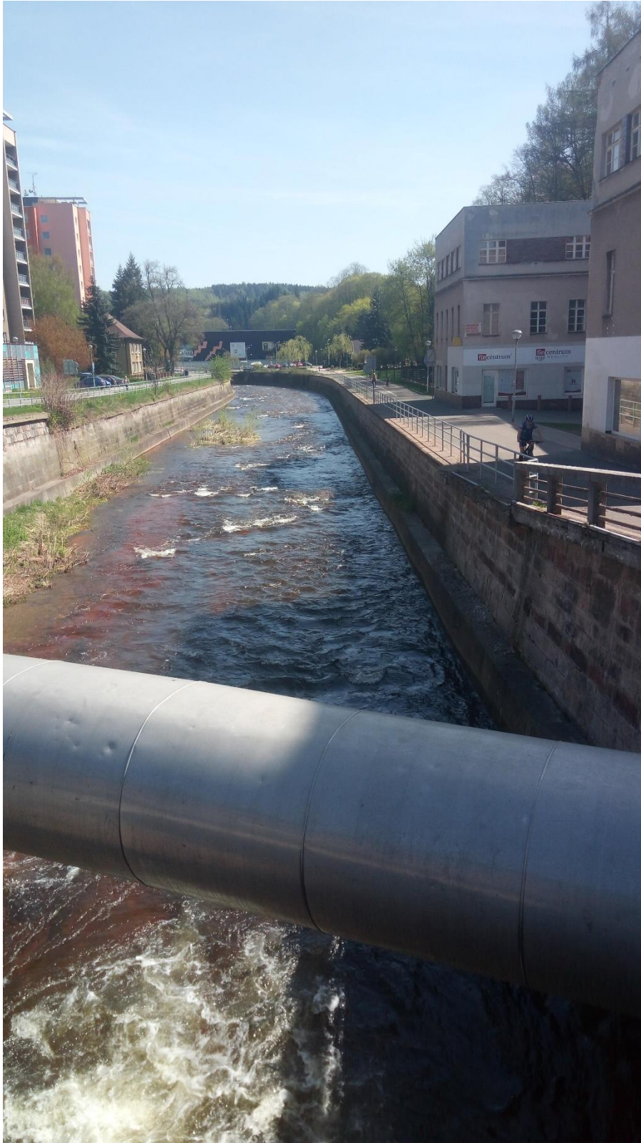
Obrázek č.14 Zrekonstruované nábřežní zdi v Trutnově, duben 2018. Autor: vlastní.
