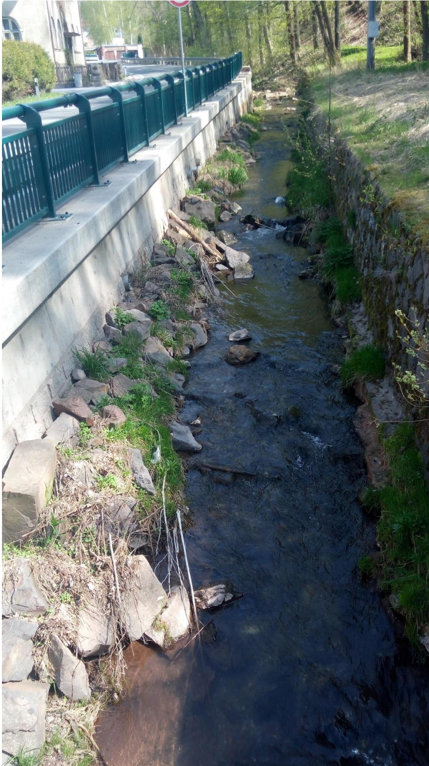
Obrázek č. 18 Levobřežní zeď v obci Rudník, duben 2018. Autor: vlastní.
