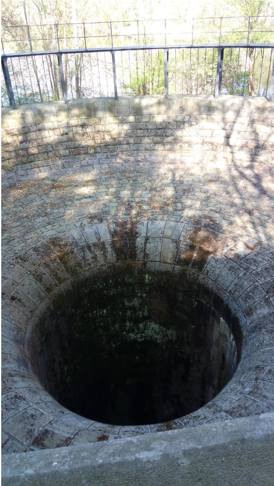
Obrázek č. 12 Nově zrekonstruovaná pravá výpust na vodním díle Les Království, duben 2018. Autor: vlastní.
