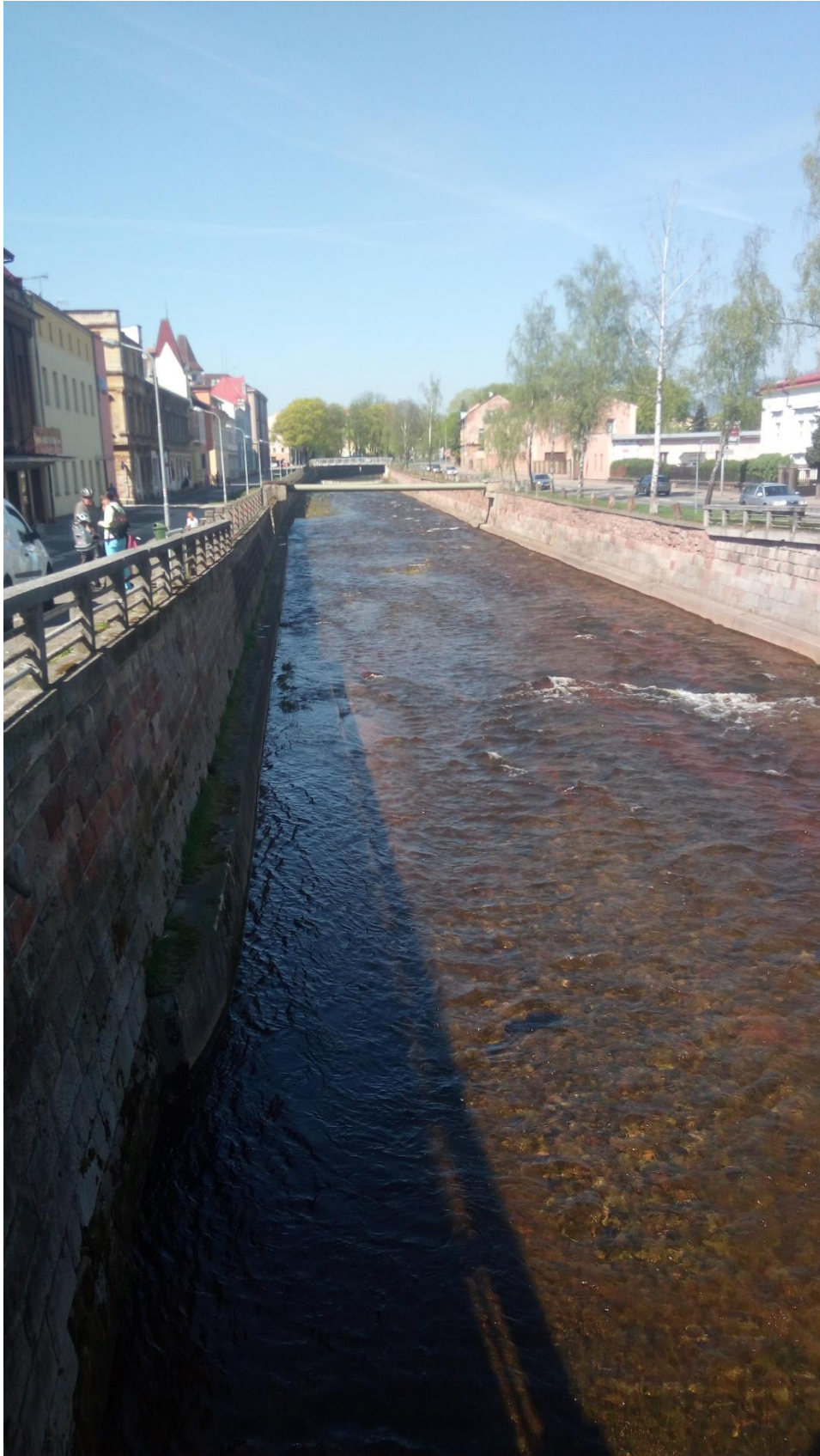
Obrázek č. 13 Zrekonstruované nábřežní zdi v Trutnově, duben 2018. Autor: vlastní.
