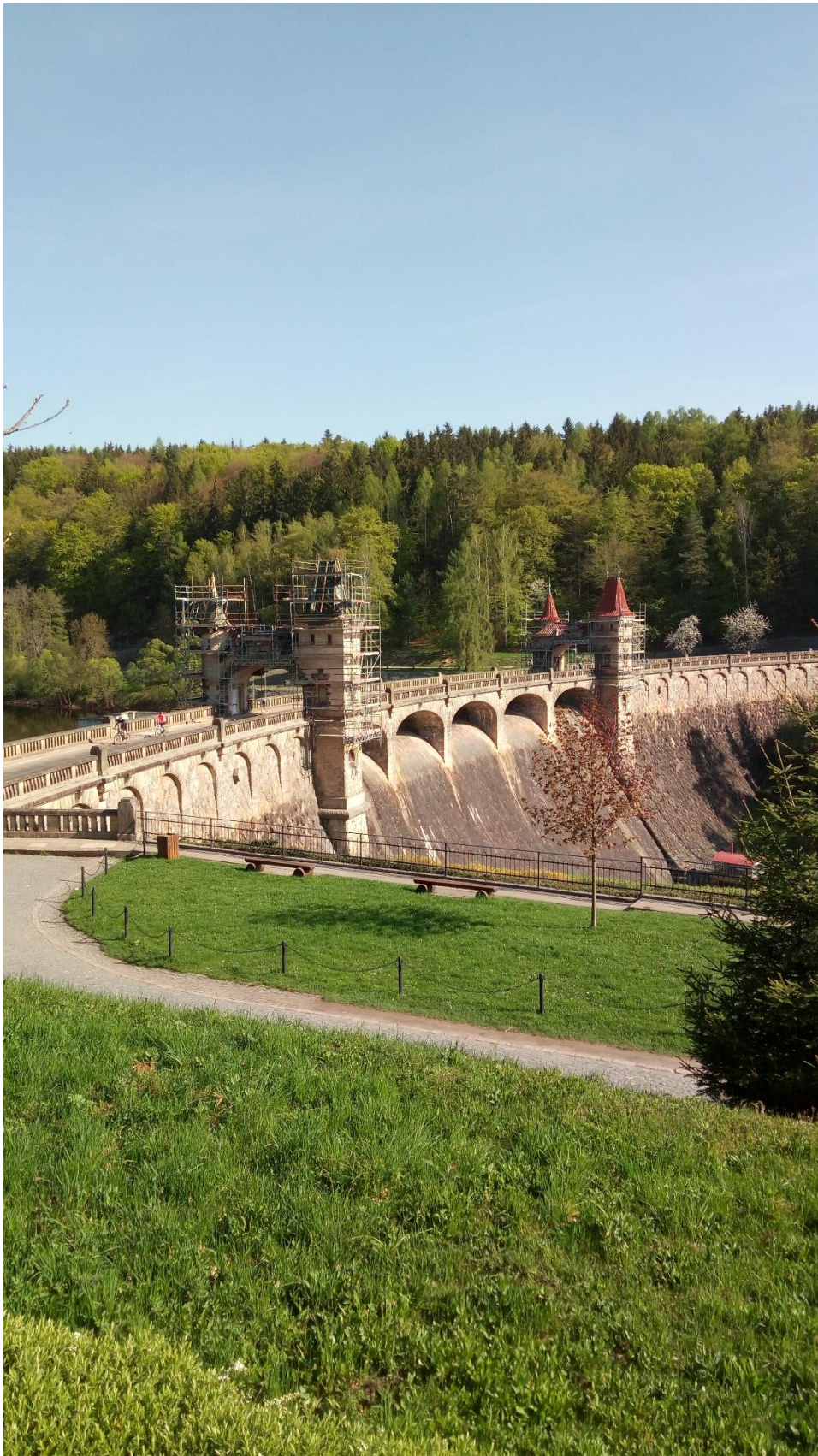
Obrázek č. 11 Právě probíhající úpravy na průjezdových věžích, duben 2018. Autor: vlastní.
