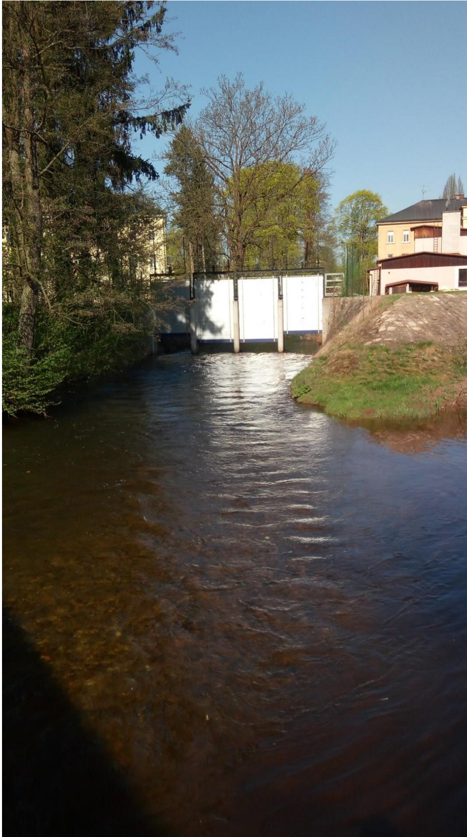
Obrázek č. 8 stavidlový uzávěr na Říčce Čistá v Hostinném, duben 2018. Autor: vlastní.
