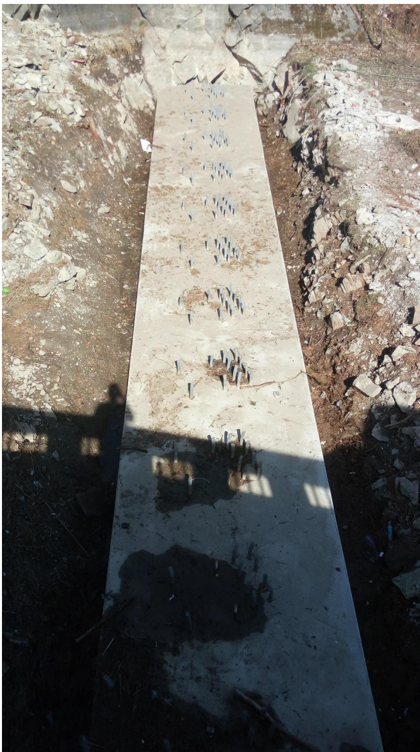
Obrázek č. 17 Základ pro hrubé česle bezpečnostního přelivu na vodním díle Labská, duben 2018. Autor: vlastní.
