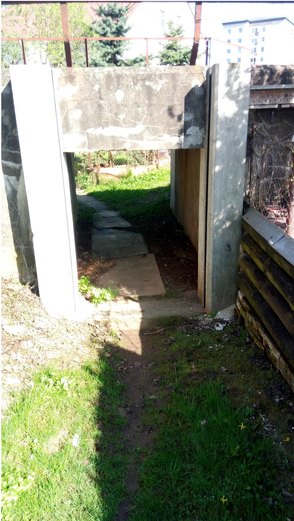
Obrázek č. 9 železniční propustek v Hostinném, duben 2018. Autor: vlastní
