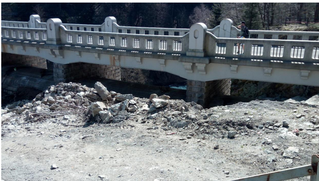
Obrázek č. 16 Korunový přeliv na vodním díle Labská, duben 2018. Autor: vlastní.
