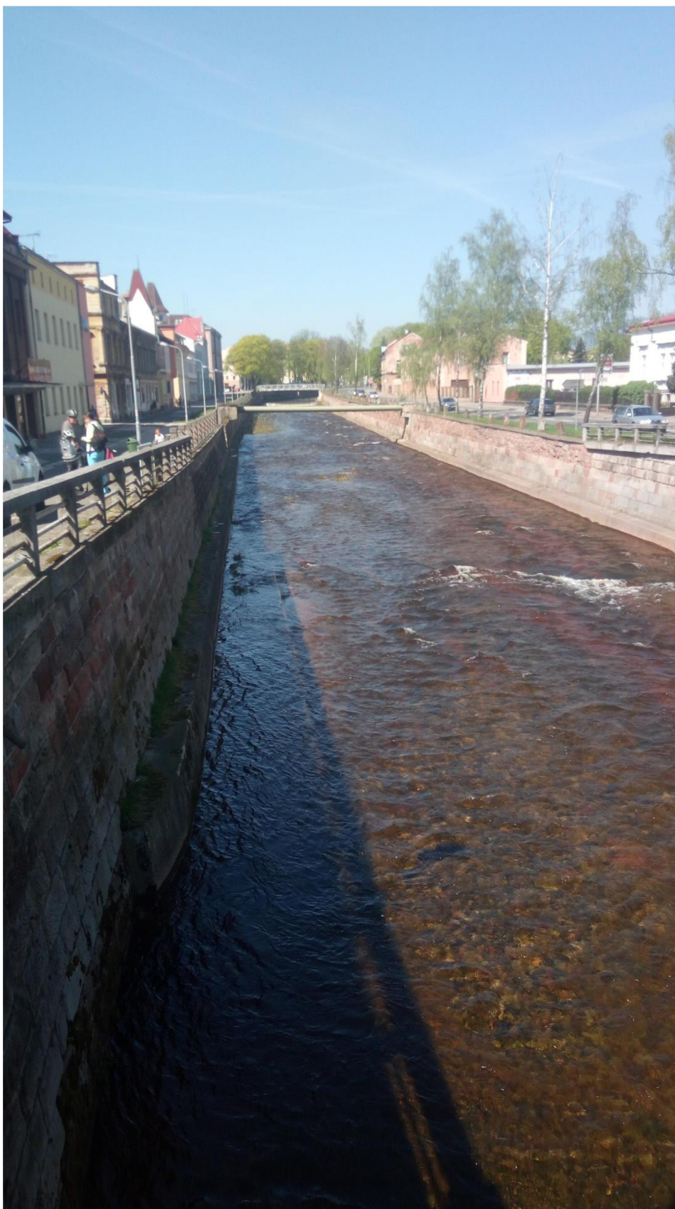
Obrázek č. 13 Zrekonstruované nábřežní zdi v Trutnově, duben 2018. Autor: vlastní.
