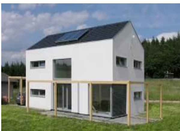
Obr. 9: Posuzovaný objekt EPD Březina – jižní pohled
