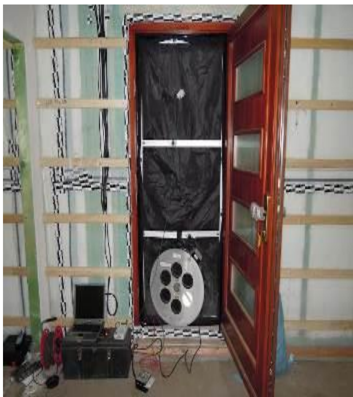
Obr. 5: Blower door test domu v Brně – Líšni, dřevostavba
