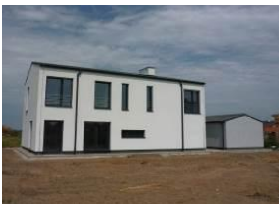
Obr. 11: Posuzovaný objekt EPD Brno Líšeň - jihozápadní pohled
