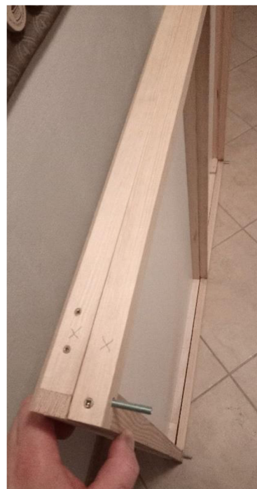
Obrázek 11 Smontovaný spodní a prostřední díl
