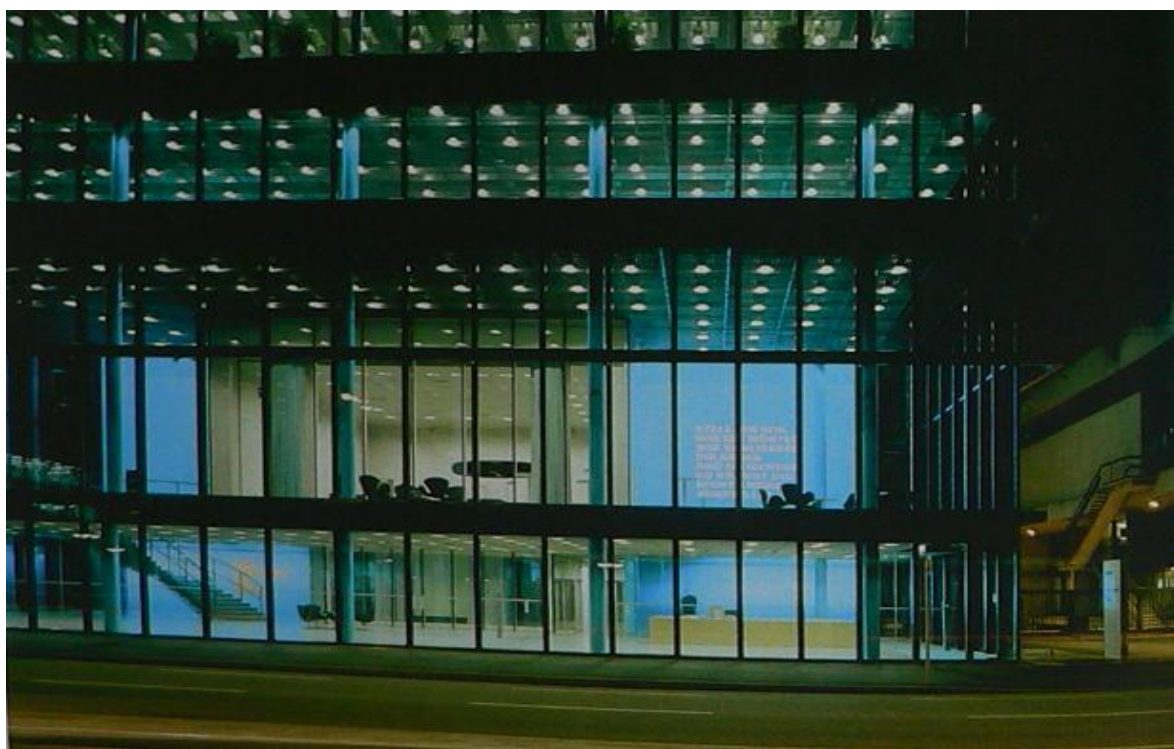
99. Herzog & de Meuron, Laboratorní a školící budovy firmy Hoffmann-La Roche , Basilej, 1994-97
