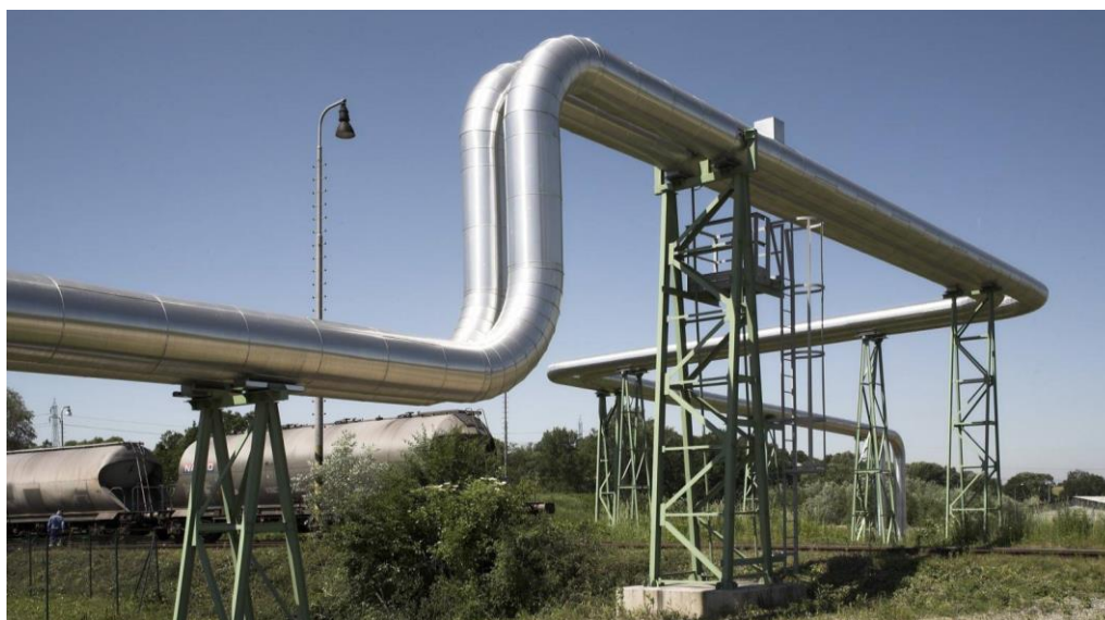
Obr. 3.8 Příklad nadzemního uložení nad železniční tratí [37]
