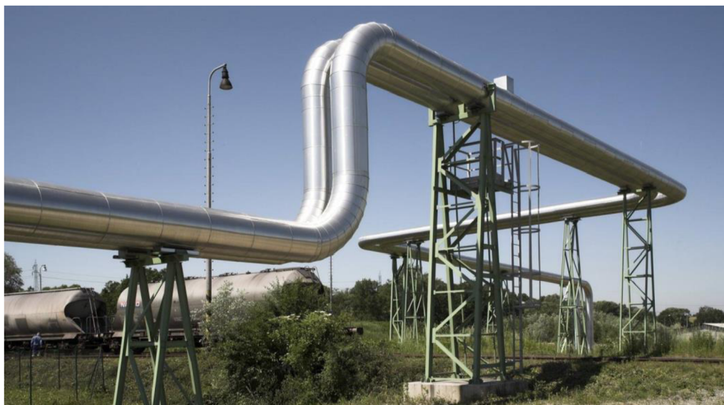
Obr. 3.8 Příklad nadzemního uložení nad železniční tratí [37]
