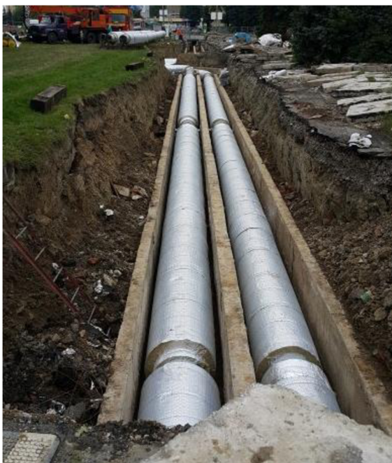
Obr. 1.7 Plášť izolace tvořený hliníkovou fólií (potrubí v neprůlezném kanálu) [26]
