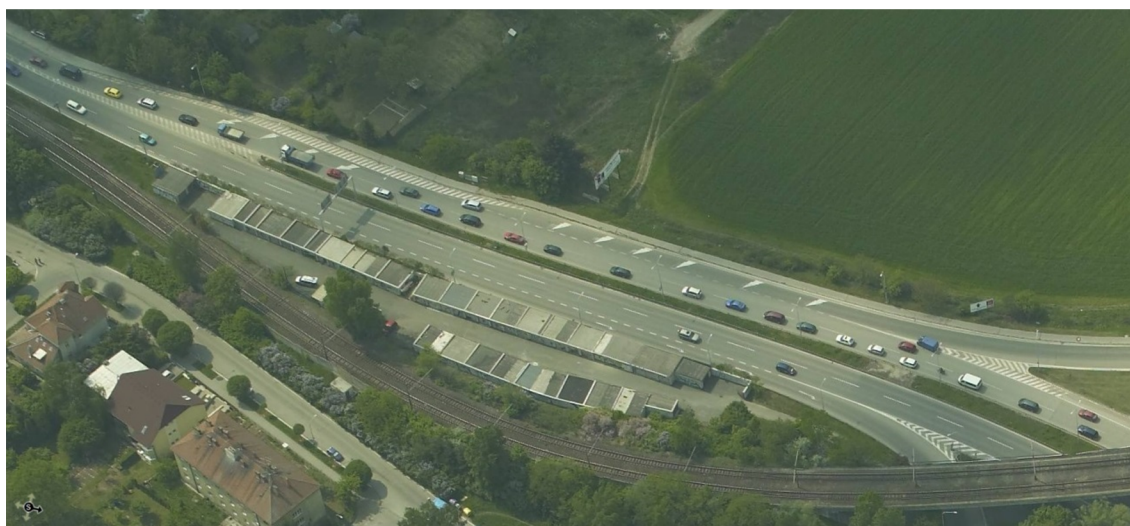
Obr. 4.2 „Ptačí pohled“ ve směru na západ. [12]
