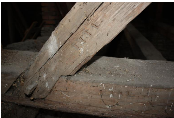
Obr. 12 detail tesařské značky na krovu nad hlavní lodí
