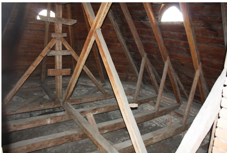
Obr. 15 krov presbytáře kostela sv. Jakuba ve Staré Vsi u Bilovce
