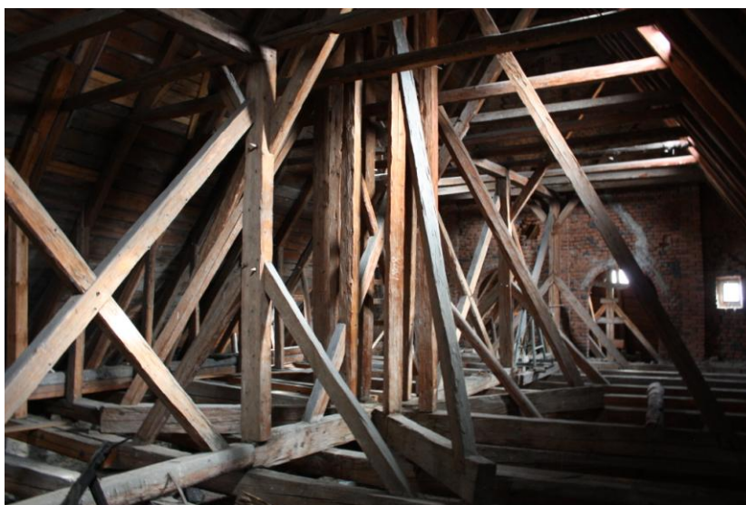
Obr. 11 Krov nad hlavní lodí kostela sv. Jakuba ve Staré Vsi u Bílovci
