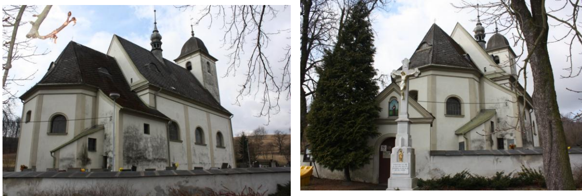
Obr. 2 Kostel sv. Jakuba ve Staré Vsi u Bílovce
