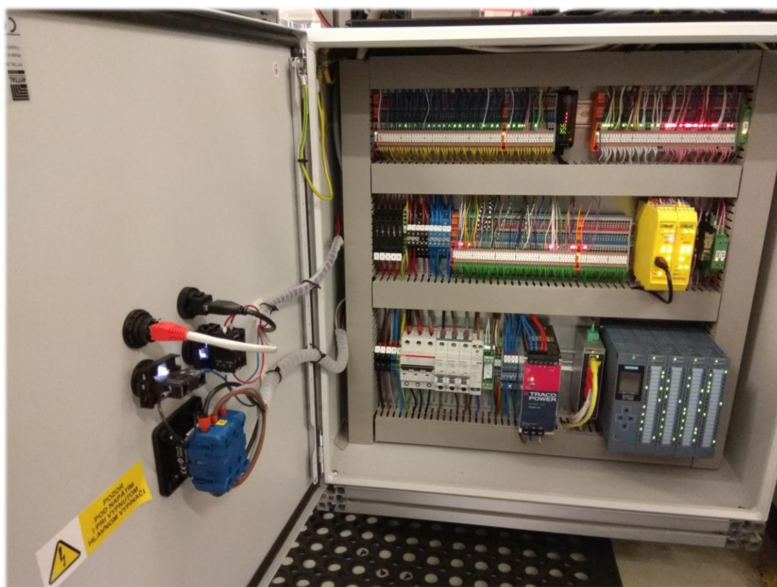
Obr. 27: Výsledné zapojenie rozvádzača
