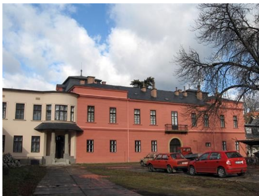
2. Severní křídlo z vnitřního nádvoří.
