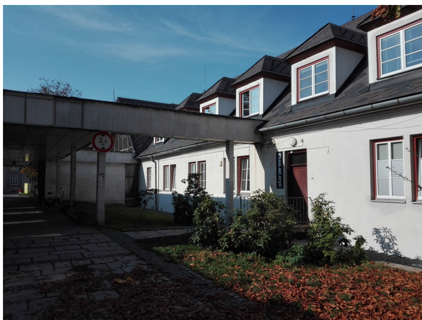
7. Jižní křídlo s nosnými trámy Kulturního domu.
