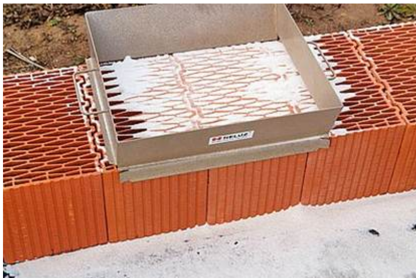
Obr. 28: Aplikace perlitu do první vrstvy keramických zdících tvarovek [30].
