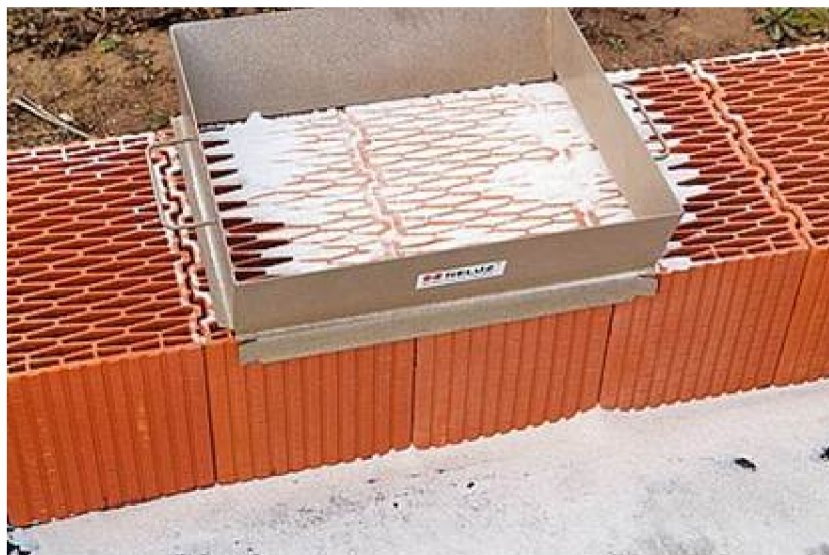
Obr. 28: Aplikace perlitu do první vrstvy keramických zdicích tvarovek [30].
