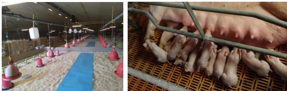
Obr. 16-17 podlahy v provozech živočišné výroby, vlevo drůbežárna firmy Moras Moravy, provoz Slepotic, materiál podlahy pravděpodobně beton, na něm pilinová podestýlka, na ní pak plastové pláty, vpravo vepřín firmy Moras Moravy, provoz Moravy, materiál podlahy plastové rošty, bočnice pozinkovaná ocel, zdroj: http://www.moras-as.cz/moras-as/7-FOTOGALERIE/25-2018 , 2024
