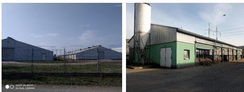
Obr. 18-19 zemědělské objekty pro živočišnou výrobu, vlevo objekt firmy Moras Slepotic – chov kuřat a slepic, vpravo pak objekt s rolovací boční plachtou firmy ZEPO Bělohrad a.s., Lázně Bělohrad – chov krav, produkce mléka, zdroj: autor práce, 2024
