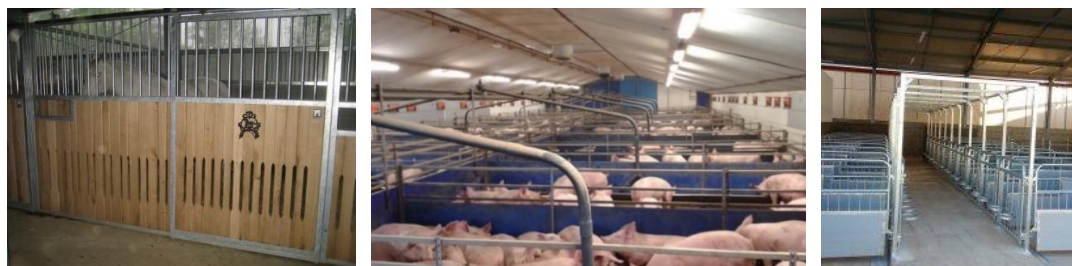
Obr. 13-15 stěny boxů v reálných provozech, vlevo box pro koně – boční stěny ze dřeva v U-profilech a kovové konstrukci, propagační materiál firmy Metaxo – stájové technologie, zdroj: https://www.metaxo.cz/produkty/kone/vnitni-boxy/ , 2024, uprostřed chov prasat, boční stěny z materiálu plast, areál firmy Moras Slepovice, Moravany, zdroj: http://www.moras-as.cz/moras-as/7-FOTOGALERIE/25-2018 , 2018, vpravo chov telat, boční stěny z pozinkované oceli, zdroj: http://www.zepo-belohrad.cz/o-firme , 2024
