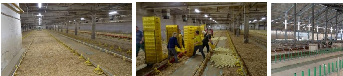
Obr. 20-22 střešní konstrukce a podpěrné sloupy, vlevo a uprostřed areál firmy Moras Slepovice, Moravany, zdroj: http://www.moras-as.cz/moras-as/7-FOTOGALERIE/ , vpravo areál firmy ZEPO Bělohrad a.s., Lázně Bělohrad, zdroj: http://www.zepo-belohrad.cz/o-firme , 2024
