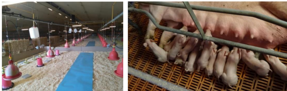
Obr. 16-17 podlahy v provozech živočišné výroby, vlevo drůbežárna firmy Moras Moravy, provoz Slepovice, materiál podlahy pravděpodobně beton, na něm pilinová podestýlka, na ní pak plastové pláty, vpravo vepřín firmy Moras Moravy, provoz Moravy, materiál podlahy plastové rošty, bočnice pozinkovaná ocel, zdroj: http://www.moras-as.cz/moras-as/7-FOTOGALERIE/25-2018 , 2024
