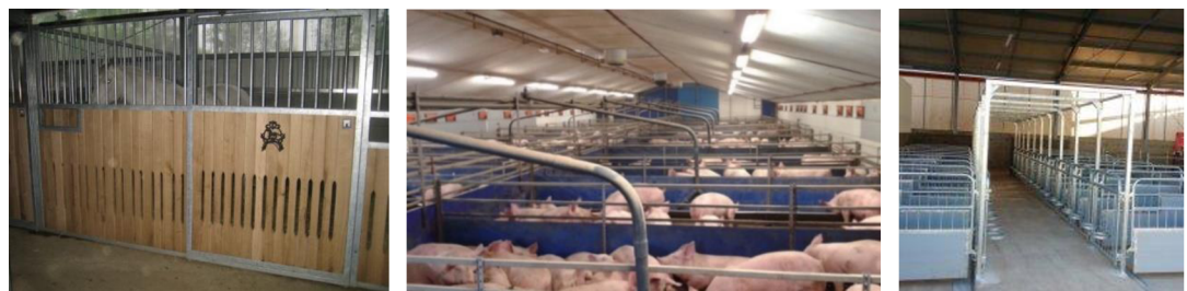
Obr. 13-15 stěny boxů v reálných provozech,
