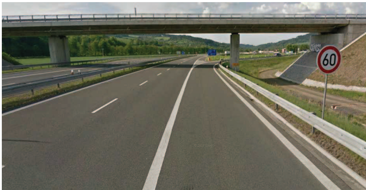
Obrázek 1: Úsek km 0,000, začátek řešeného úseku – tento obrázek je jen orientační, pro znázornění začátku úseku rekonstrukce zkapacitnění silnice I/57
