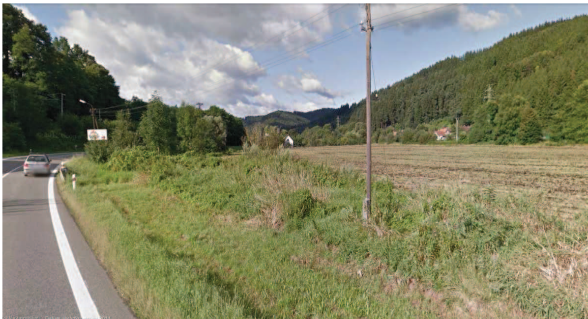
Obrázek 14: Konec řešeného úseku - km 8,734
