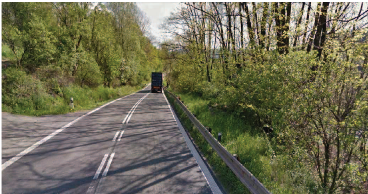
Obrázek 7: Pohled na úseku km 3,119 – stávající komunikace I/57 ze směru z Bystřičky do Jablůnky, nejvyšší bod stávající komunikace
