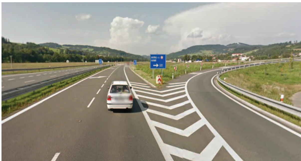
Obrázek 2: Úsek km 0,100, pohled na odbočovací pruh ve směru Ratiboř
