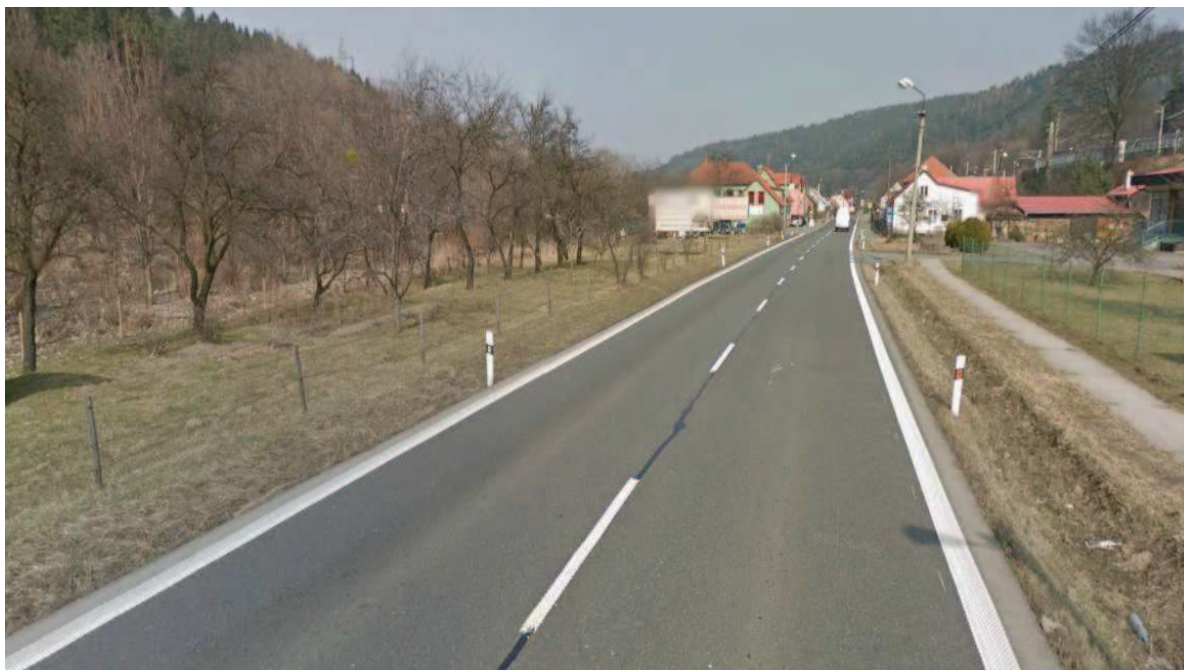
Obrázek 13: Pohled na úseku km 7,730 – vjezd do obce Valašské Meziříčí Podlesí
