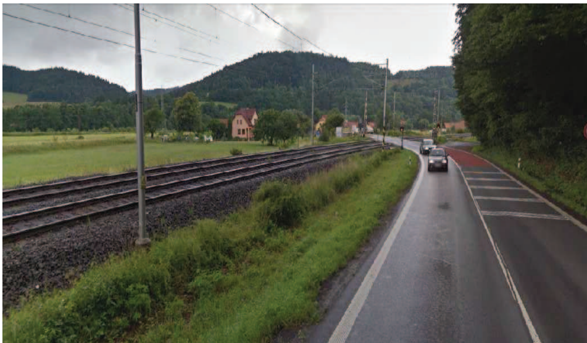
Obrázek 9: Pohled na úseku km 4,673 – křížení stávající komunikace I/57 se železnicí před obcí Bystřička
