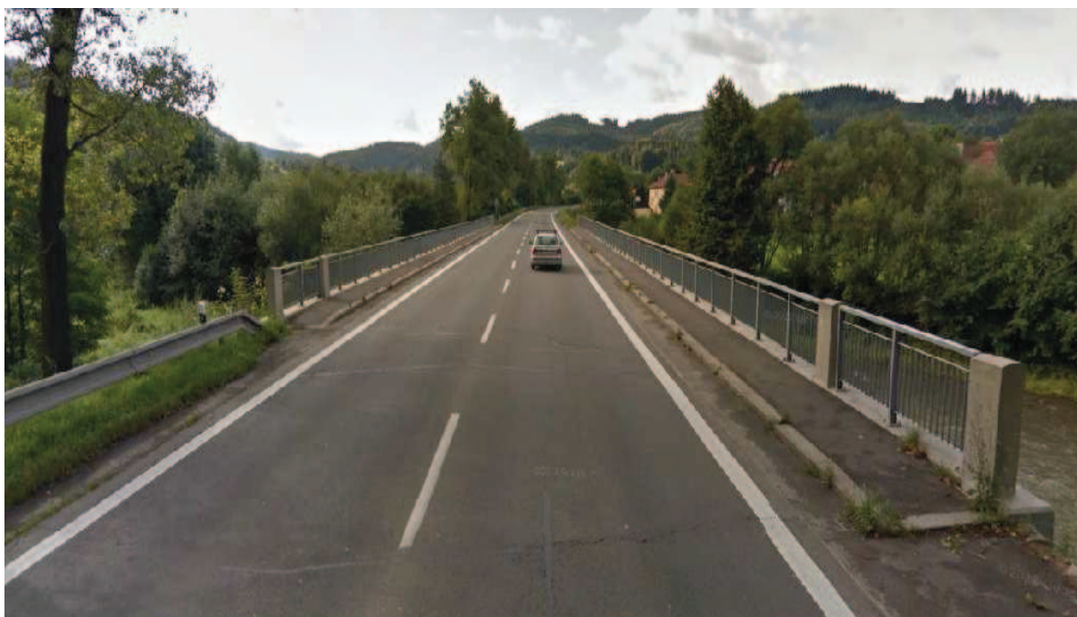
Obrázek 12: Pohled na úseku km 6,131 – most přes Vsetínskou Bečvu
