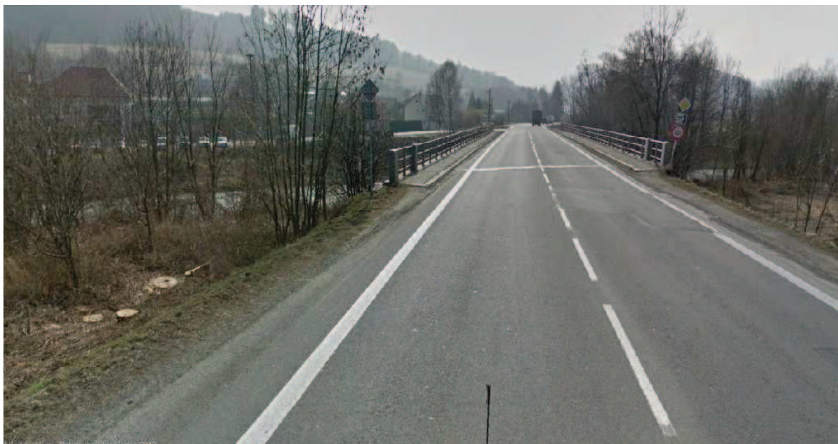
Obrázek 11: Pohled na úseku km 5,530 – most přes Vsetínskou Bečvu v Obci Bystřička
