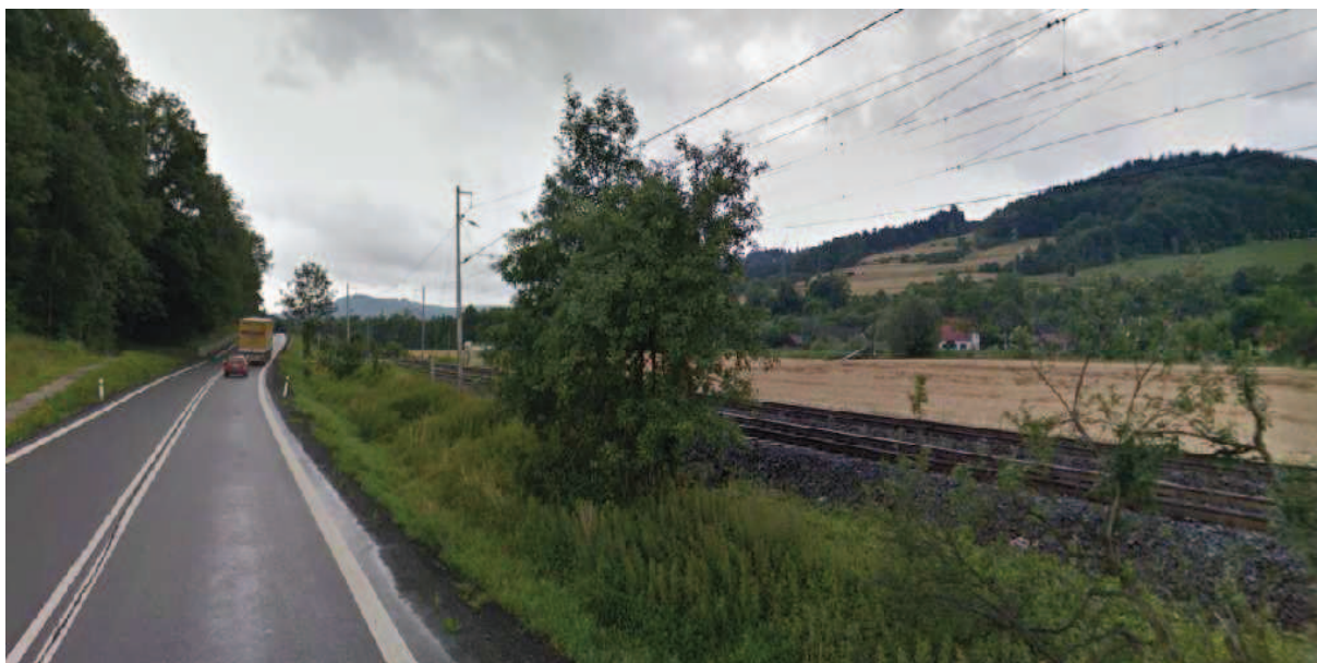
Obrázek 8: Pohled na úseku km 3,733 – stávající komunikace I/57
