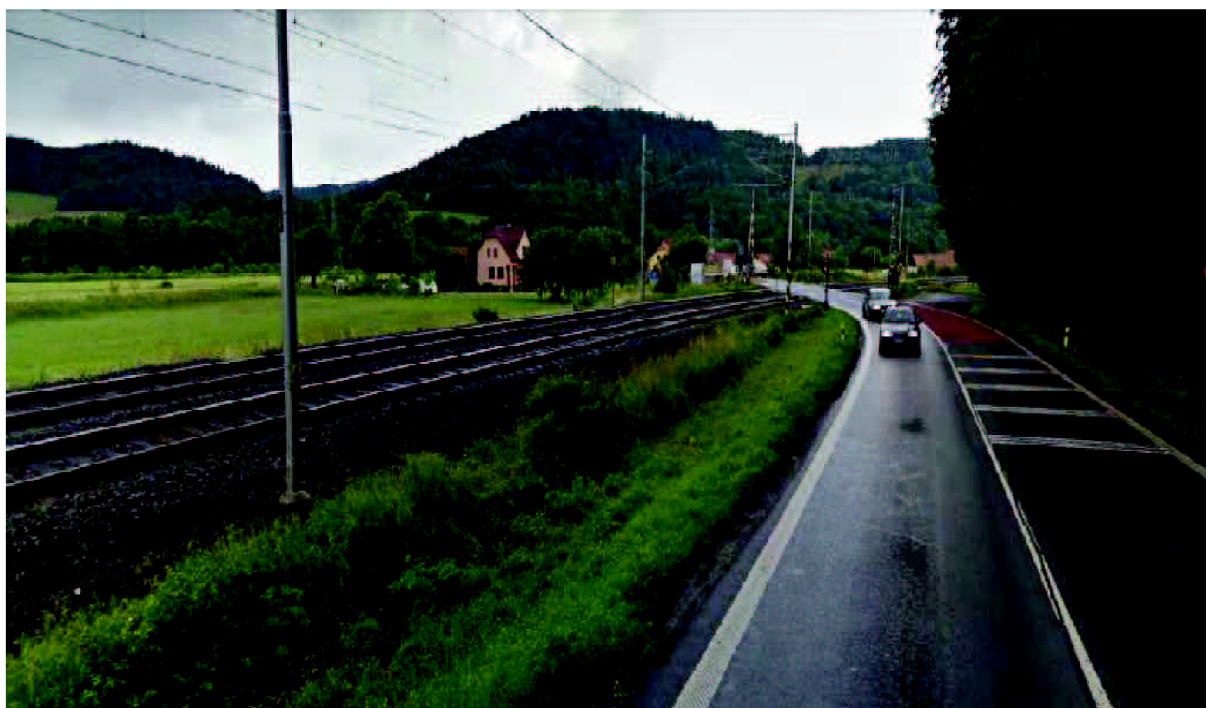
Obrázek 9: Pohled na úseku km 4,673 – křížení stávající komunikace I/57 se železnicí před obcí Bystřička
