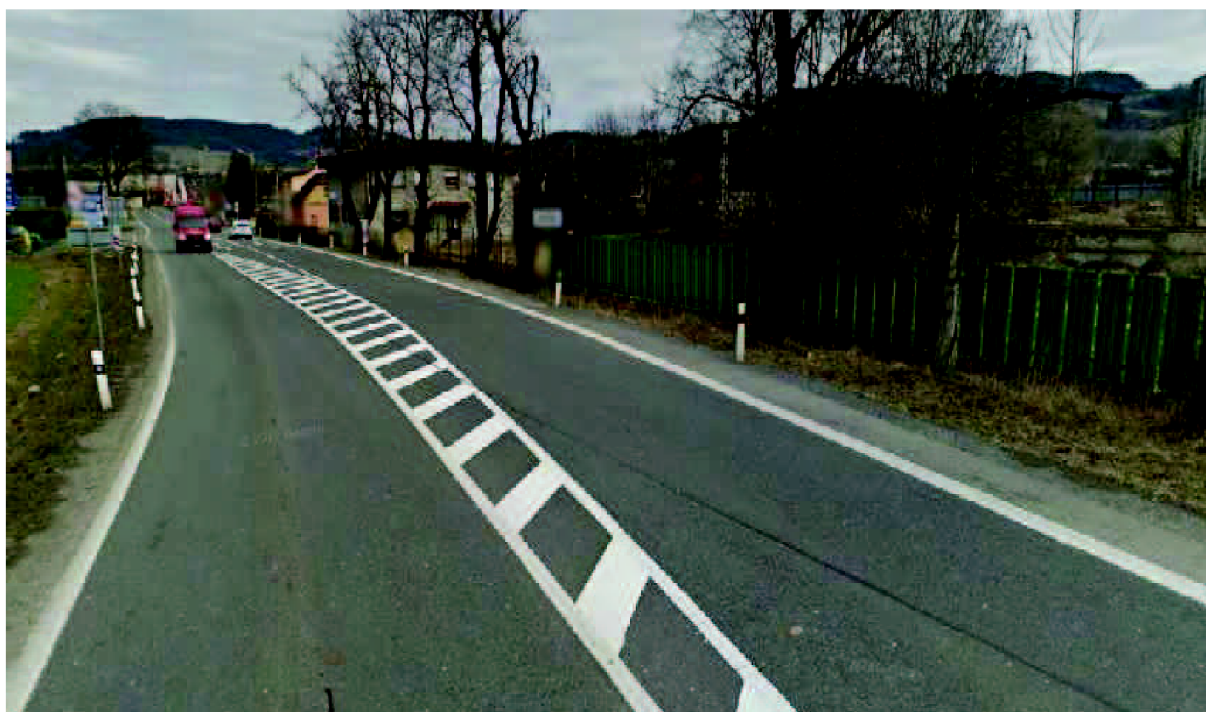
Obrázek 4: Stávající komunikace I/57 – vjezd do obce Jablůnka ze směru od Vsetína
