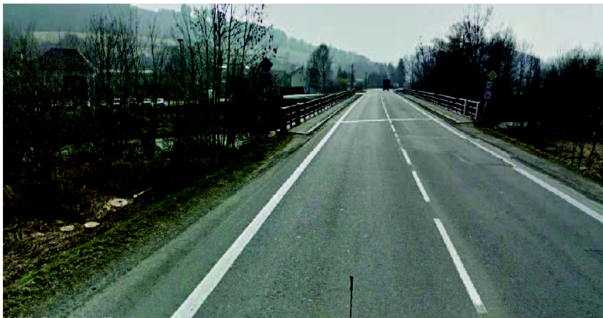
Obrázek 11: Pohled na úseku km 5,530 – most přes Vsetínskou Bečvu v Obci Bystříčka
