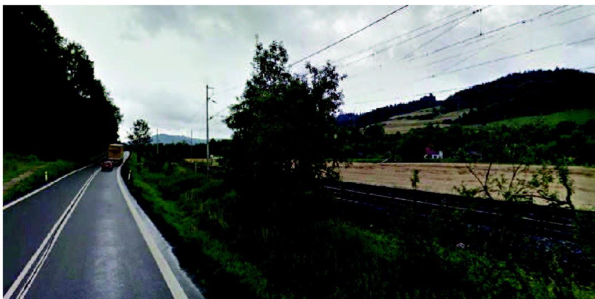
Obrázek 8: Pohled na úseku km 3,733 – stávající komunikace I/57
