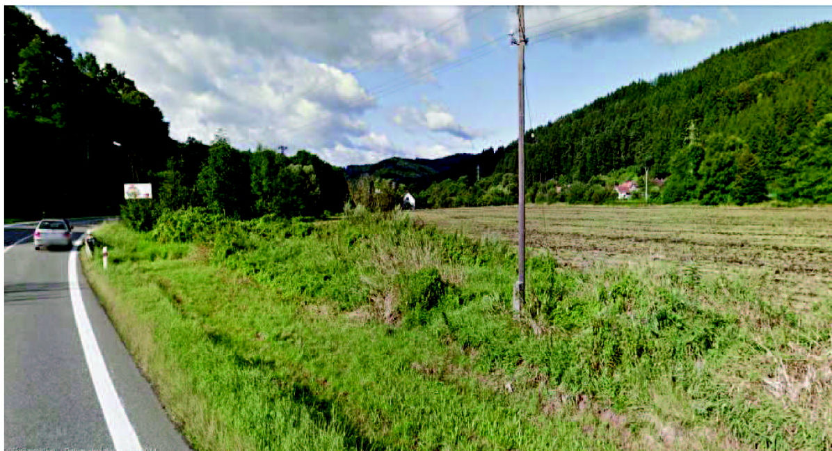
Obrázek 14: Konec řešeného úseku - km 8,734
