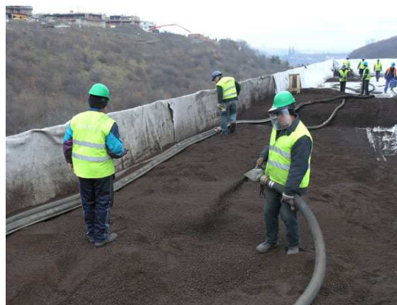
Obr. 12: Realizace střešního substrátu Zdroj: www.casopisstavebnictvi.cz
