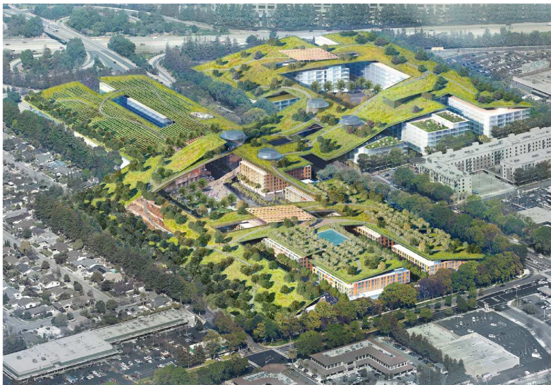
Obr. 50: Budoucí největší zelená střecha světa v Silicon Valley, CA, USA Autor: Rafael Viñoly and Olin Landscape Architects Zdroj: www.inhabitat.com
