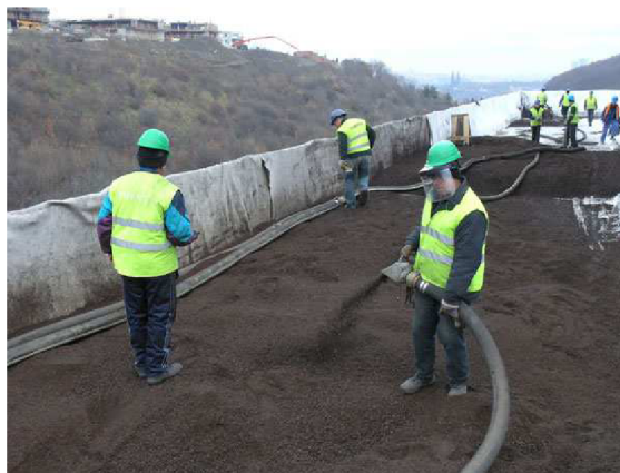
Obr. 12: Realizace střešního substrátu Zdroj: www.casopisstavebnictvi.cz
