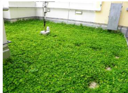
Obr. 36: Ukázka z měření teplot – zelená střecha s podzemnicí olejnou [24]
