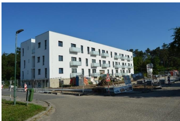
Obrázek 26 Příklad moderní bytové zástavby – ul. 9.května [Zdroj: [autor]]
