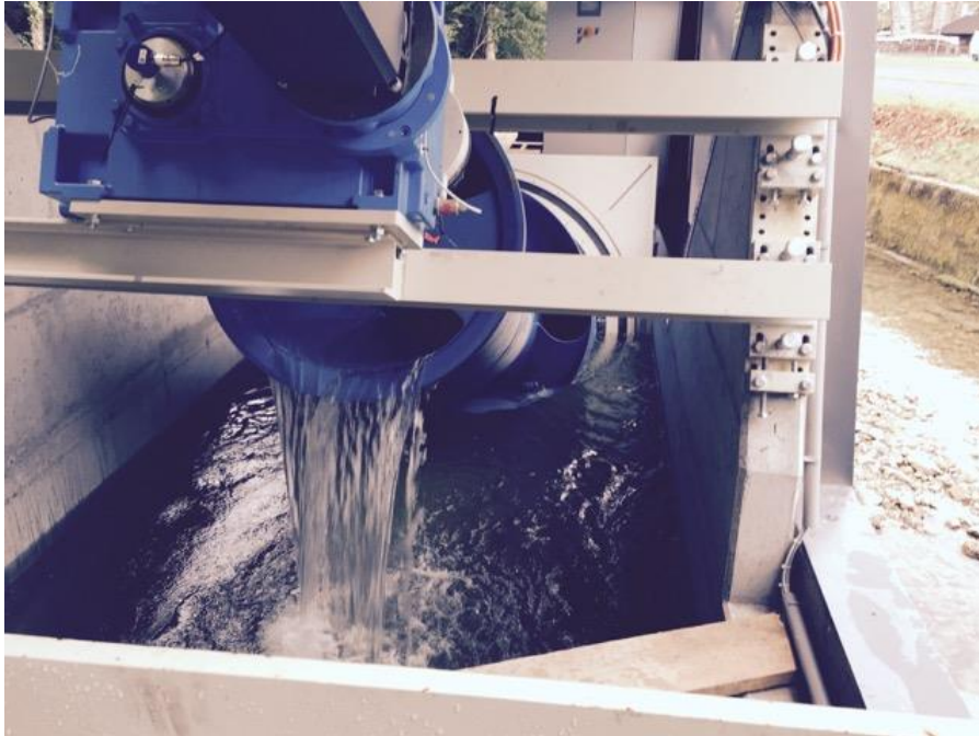
Obrázok 4: Vrchná časť rybovodu spoločnosti Hydro-connect
