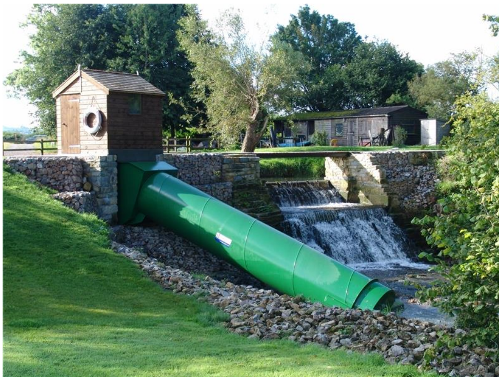
Obrázok 3: RST turbína inštalovaná na vodnom diele [7]
