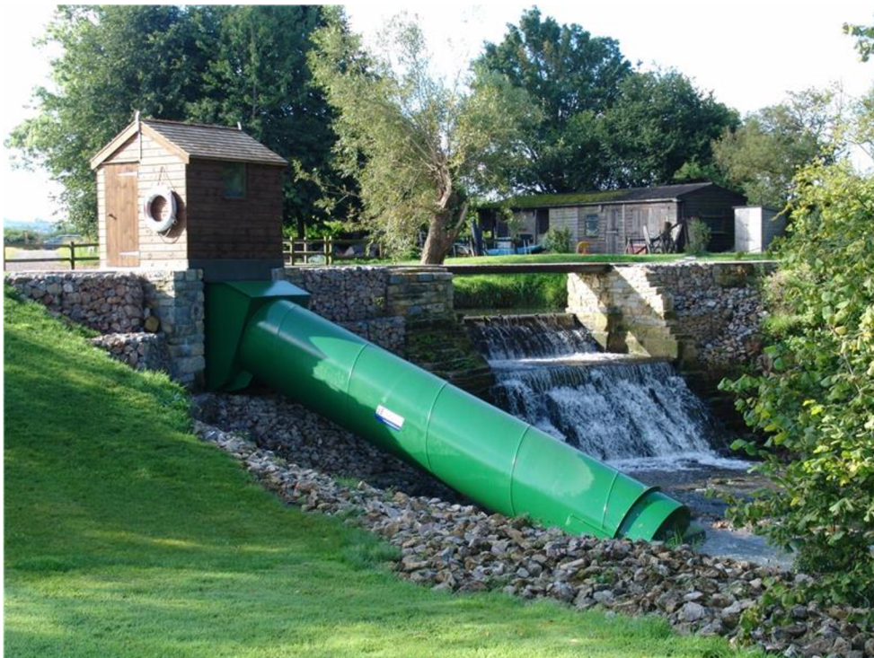
Obrázok 3: RST turbína inštalovaná na vodnom diele [7]
