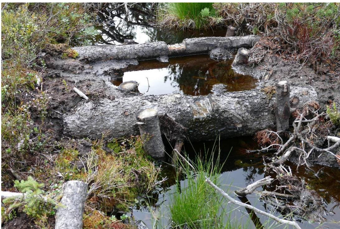
Obr. 4 Přeřrážka z dřevěné kulatiny s přeřpadovými otvory. Voda přeřrážku podtěká (Zdroj: Vlastní, pořizeno 5. 9. 2015 Velký močál)
