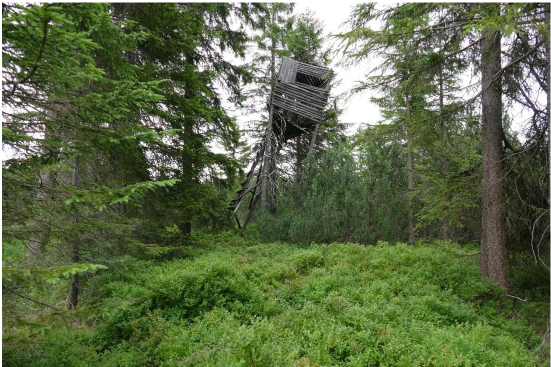
Obr. 13 Chátrající kazatelna na hranici okrajového laggu vrchoviště (Zdroj: Vlastní, pořizeno 1. 8. 2015 Velký močál)
