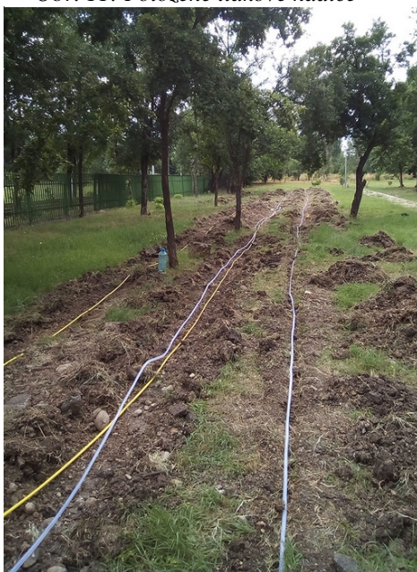
Obr. 11: Položené tlakové hadice [15]
