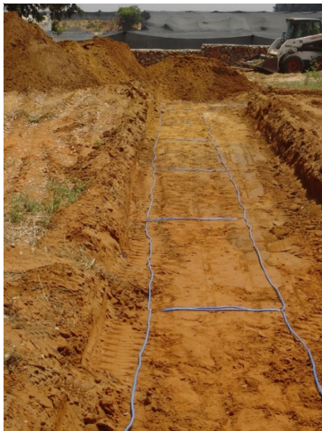
Obr. 14: Položení snímacích kabelů [13]
