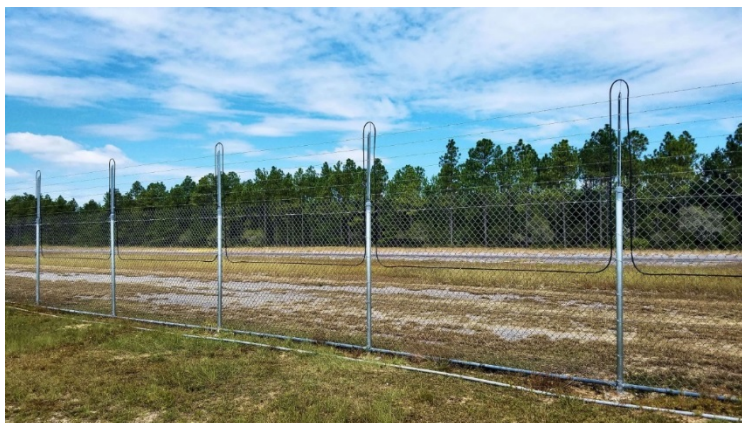
Obr. 15: Realizace ochrany perimetru pomocí Vláknové optického systému [13]
