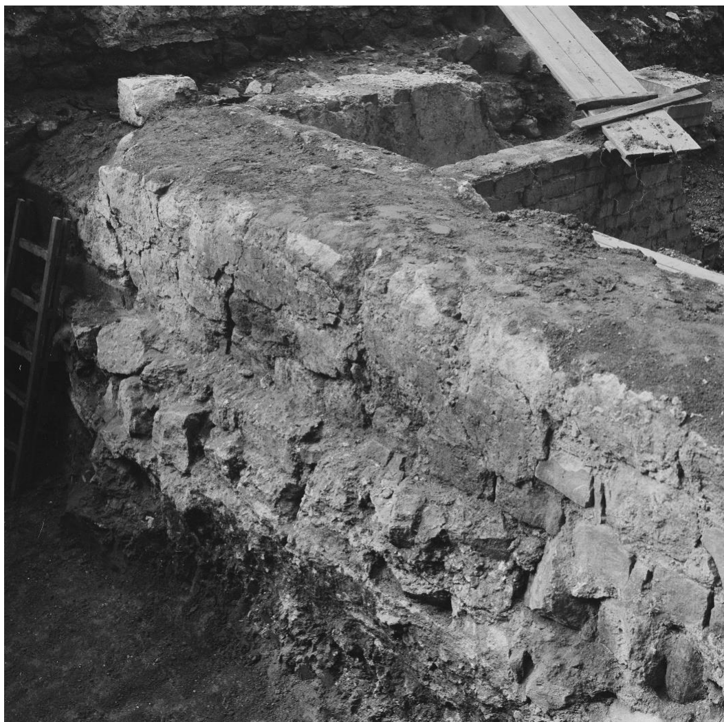
Obr. 18. Pohled na vnější zeď presbytáře románského kostela. Na nadzemním zdivu jsou vidět místa se zachovalou omítkou zdobenou bílým kvádrováním. (Archiv archeol. odd. Muzea města Brna)
