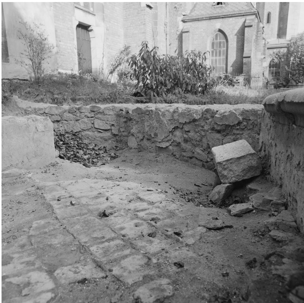
Obr. 30. První maltová podlaha kostela s negativem vytrhaných dlaždic kladených na koso. Vlevo je zachycena část oltární menzy, vpravo hrana kamenná lavice v jižní zdi presbytáře. Na stěnách dochovaného nadzemního zdiva jsou vidět zbytky vnitřních omítek. (Archiv archeol. odd. Muzea města Brna)
