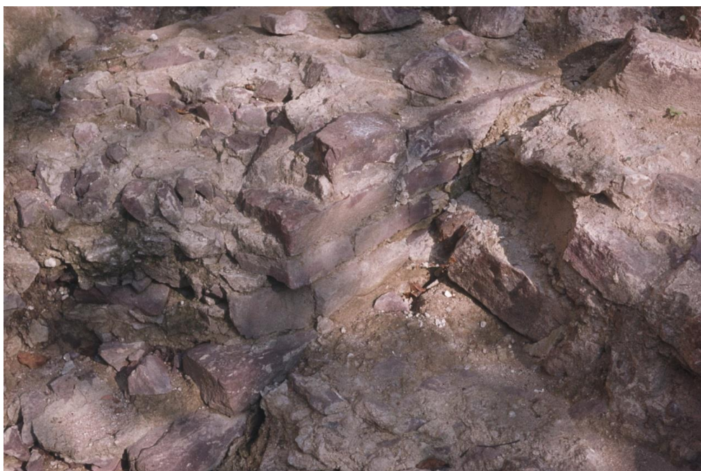
Obr. 11. Typický nafialovělý odstín stavebního kamene rotundy. Uprostřed snímku jsou vidět kvádrů vnitřního lícovaného zdiva lodi, za ním výplň síly zdiva (stavební technika emplekton). (Archiv archeol. odd. Muzea města Brna)
