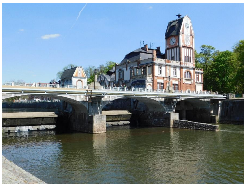
Obrázek 9: Vodárna a elektrárna
