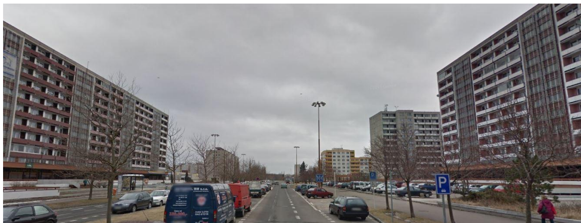
Obrázek 32: Třída Edvarda Beneše před započatou rekonstrukcí
