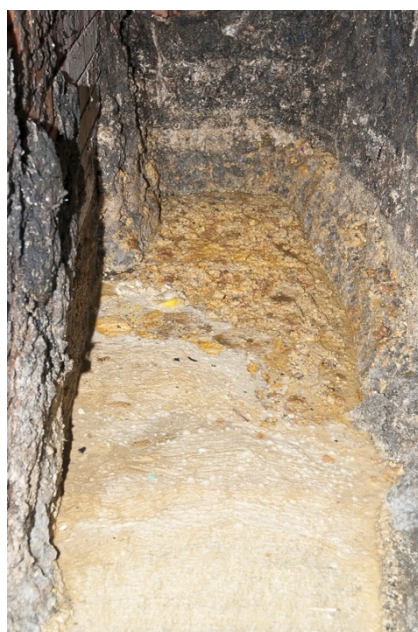
Obrázek 19: Tuk v kanalizaci (PVK, ©2024)
