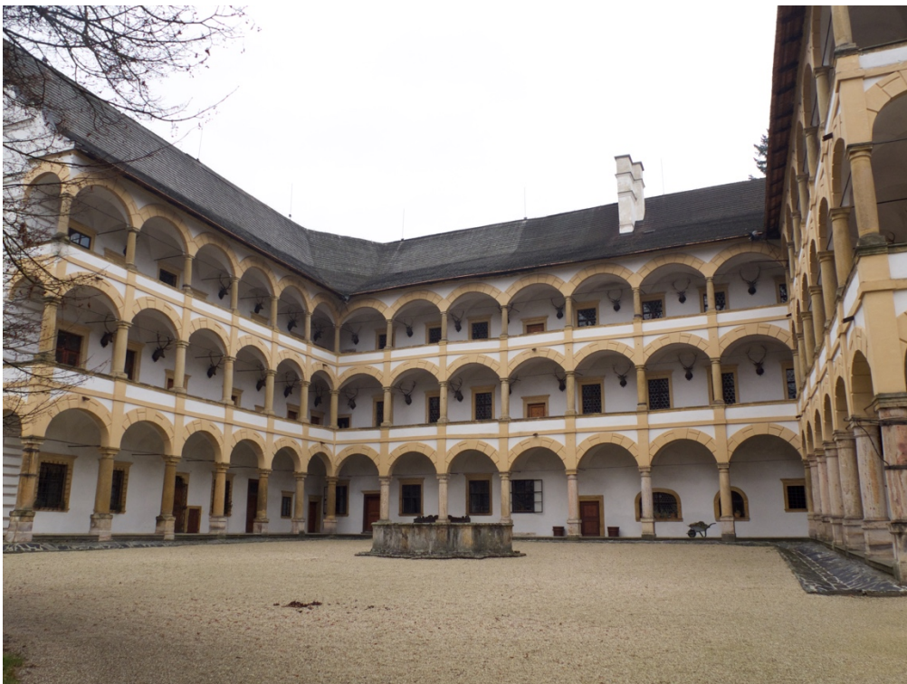
39. Velké Losiny, vysoký zámek, pohled na arkádové nádvoří od jihu, konec 16. století
