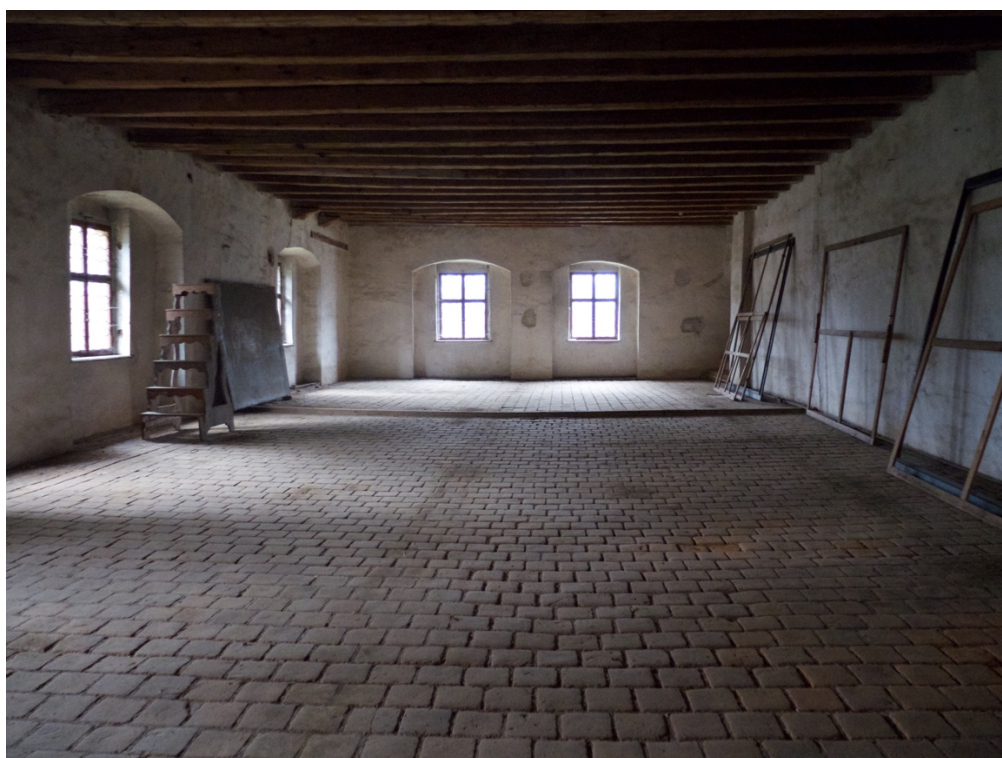
69. Velké Losiny, vysoký zámek, pohled do soudní síně, severní křídlo druhého poschodí, konec 16. století
