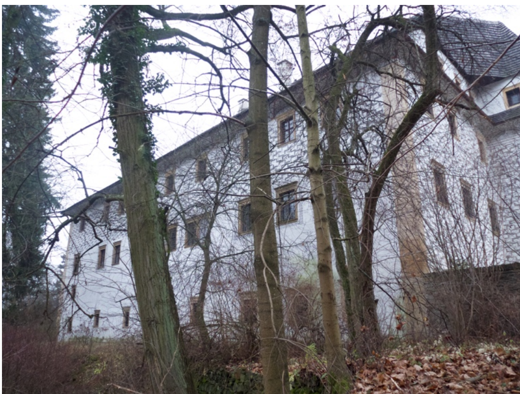
31. Velké Losiny, vysoký zámek, pohled ze severu, konec 16. století
