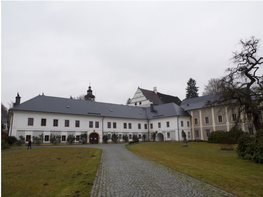
38. Velké Losiny, zámek, pohled od východu, 19. století
