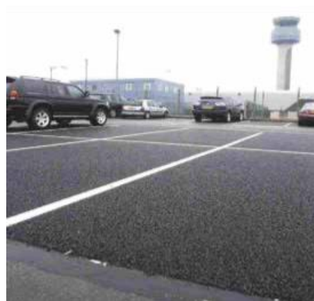
Obr. 6: Parkoviště na letišti East Midlands s porézním asfaltovým povrchem (Ballard et al., 2015)
