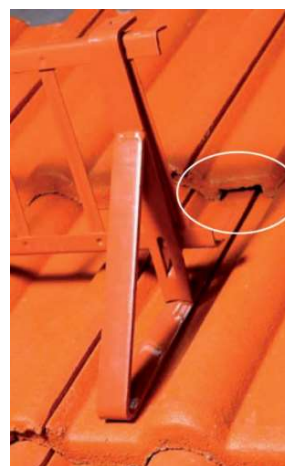
Obrázek 32 - Drážka pro průchod konstrukce držáku sněholamu [1]
