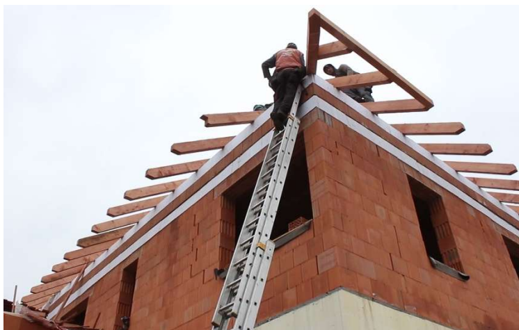
Obrázek 16 - Ilustrativní ukázka podepření krokví v okapní hraně [11]
