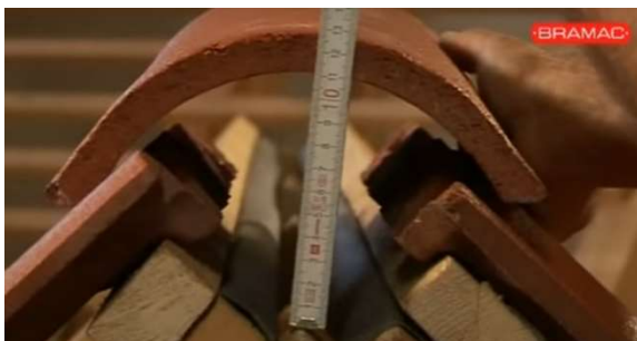
Obrázek 35 - Určení výšky hřebenové latě [1]
