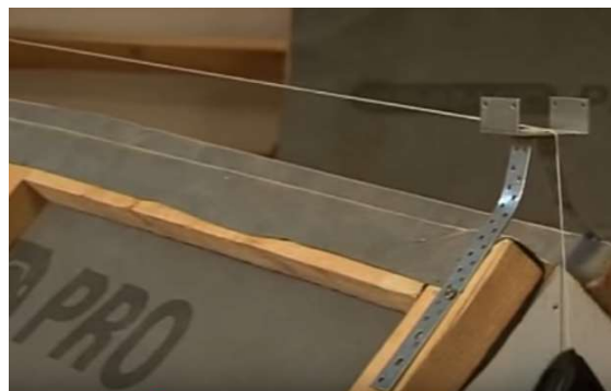
Obrázek 36 - Montáž držáku latě [1]
