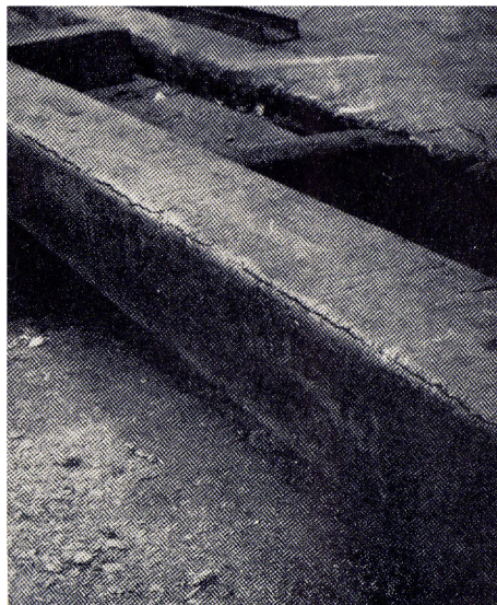
Obrázek 2.3: Podélná trhlina v rohu předlitku způsobená chybným návrhem chladicí soustavy [5]
