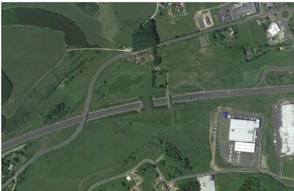
Obr. 6: Ekodukt Jenišov přes rychlostní silnici R6. Zdroj: maps.google.com
