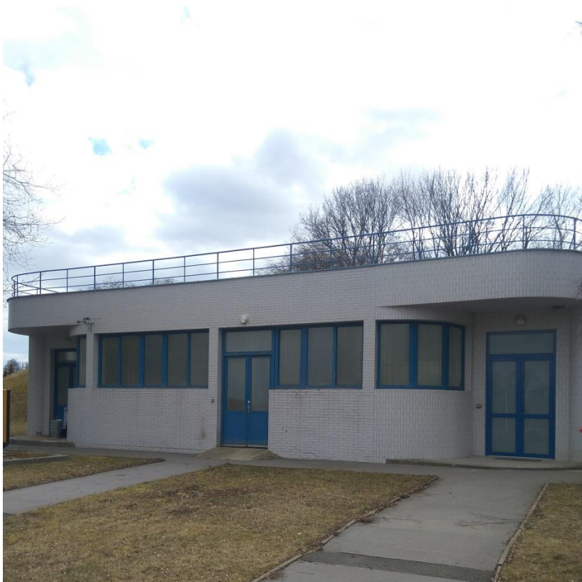
obr. č. 3 úpravna vody na Letišti Praha
